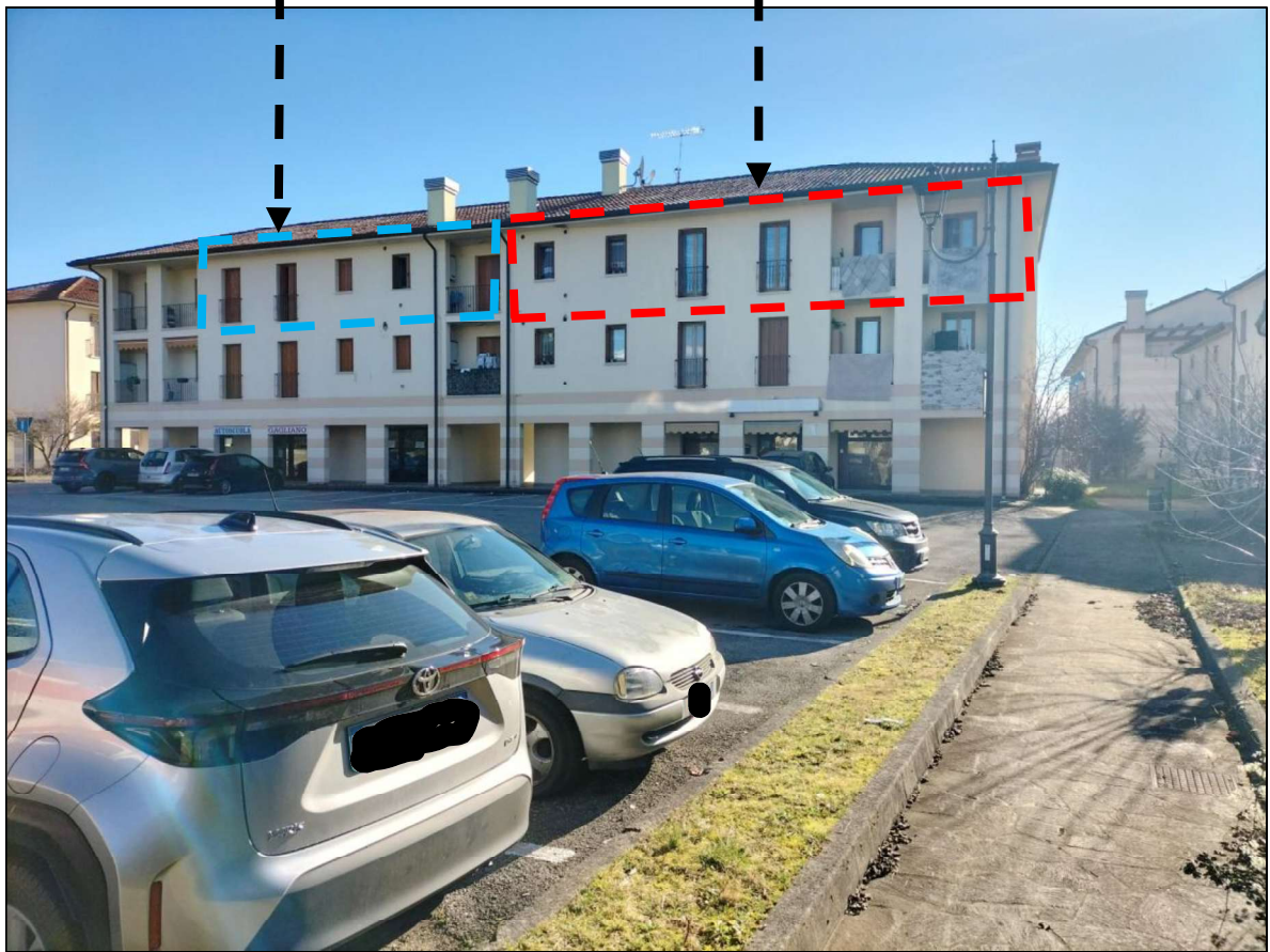
Foto – vista da Nord/Ovest del Condominio dove sono inseriti gli immobili oggetto di esecuzione
