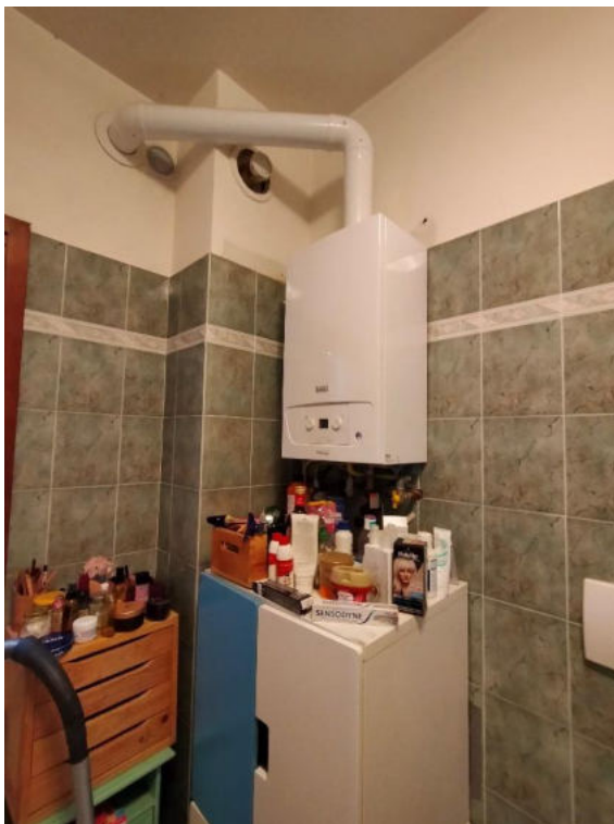
15. Generatore per riscaldamento e ACS a metano nel locale bagno e split interno per climatizzazione estiva
