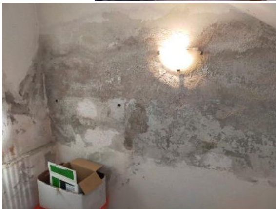
34. Criticità: umidità di risalita e umidità per infiltrazioni zona piano interrato
