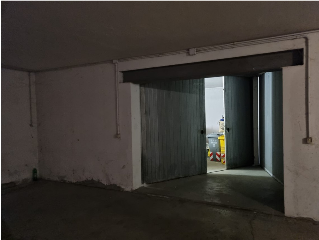
VISTA INTERNA - AUTORIMESSA
