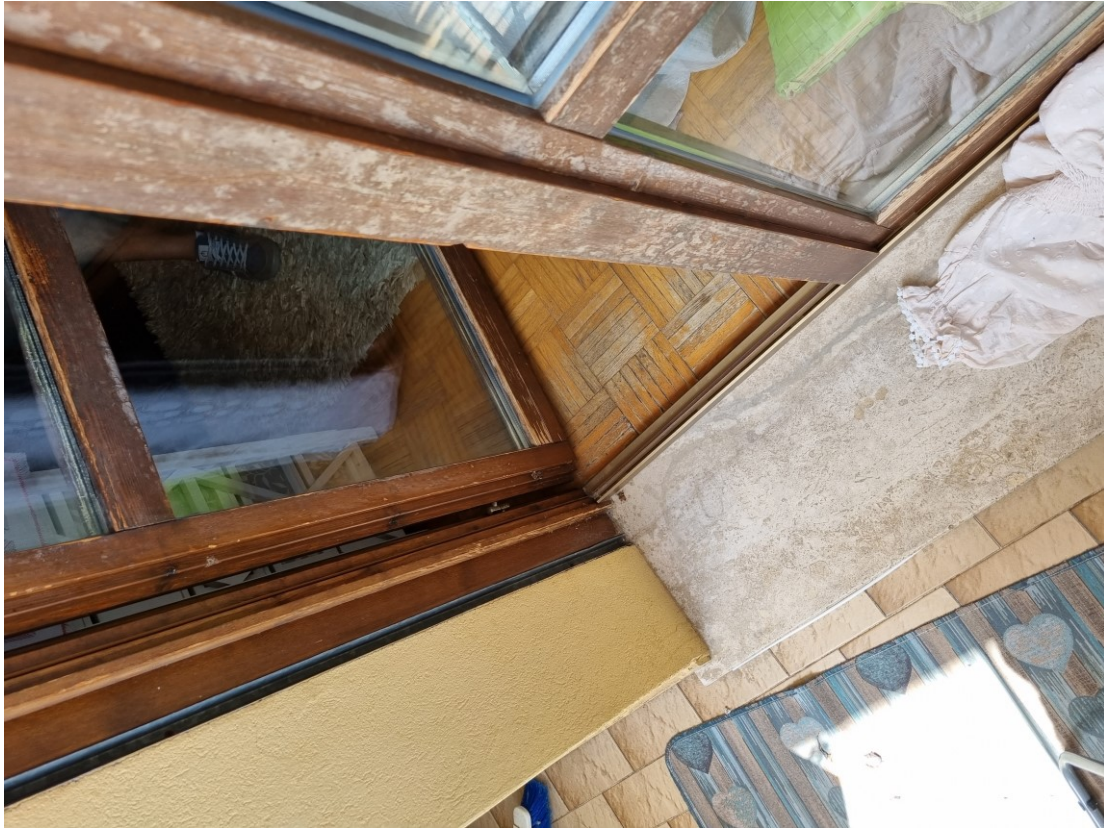
VISTA INTERNA - TERRAZZO
