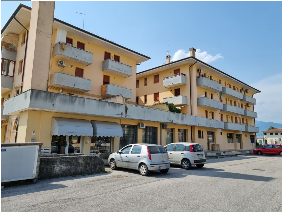
VISTA ESTERNA - FACCIATA SUD/EST
