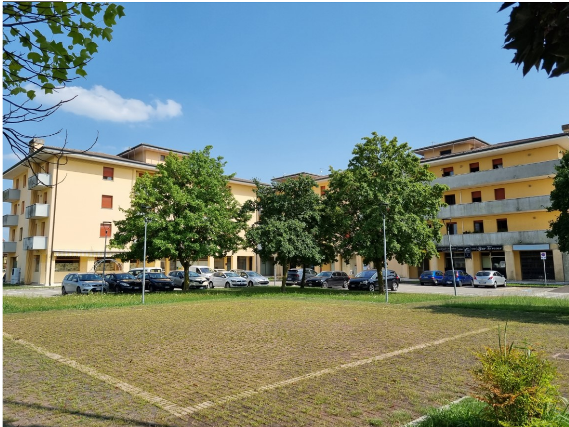
VISTA ESTERNA - FACCIATA GLOBALE NORD/OVEST
