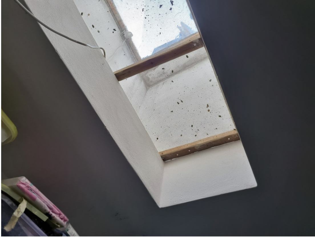
VISTA INTERNA - RIPOSTIGLIO
