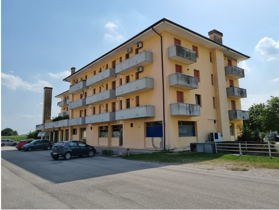
VISTA ESTERNA - FACCIATA NORD/EST
