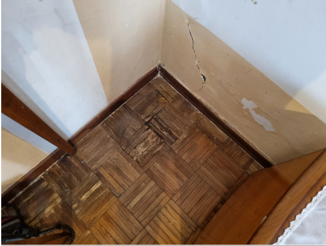
VISTA INTERNA - CAMERA
