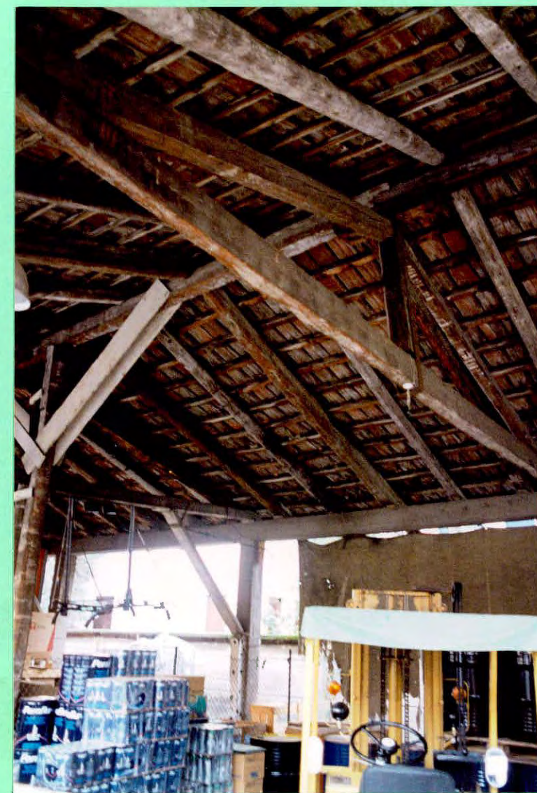
PARTICOLARE DELLA COPERTURA ESISTENTE
