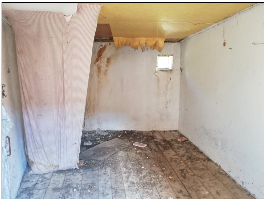
Foto 12 – Camera lato ovest piano primo
