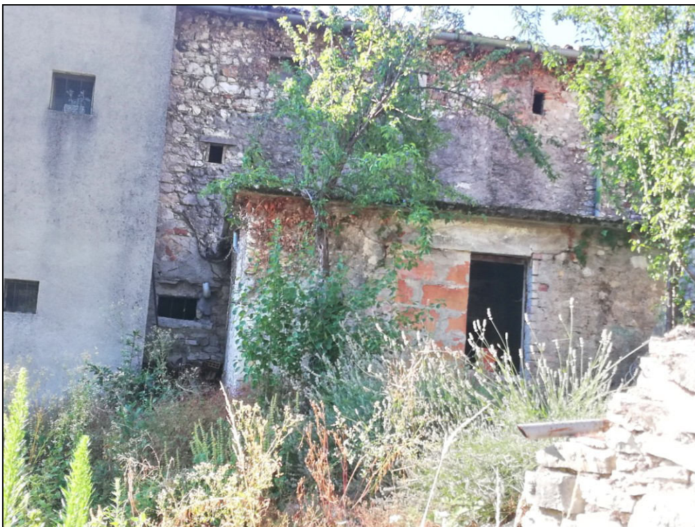
Foto 01 – Fronte nord su corte esclusiva
