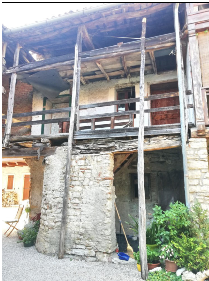
Foto 03 – Fronte sud su corte comune (mn. 638)
