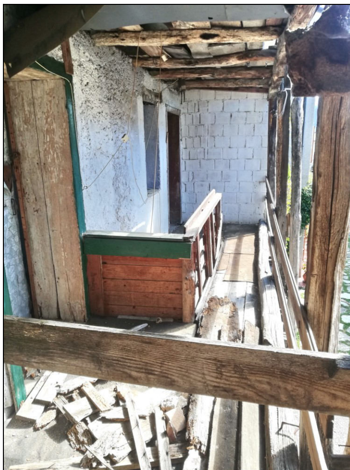
Foto 11 – Ballatoio piano primo
