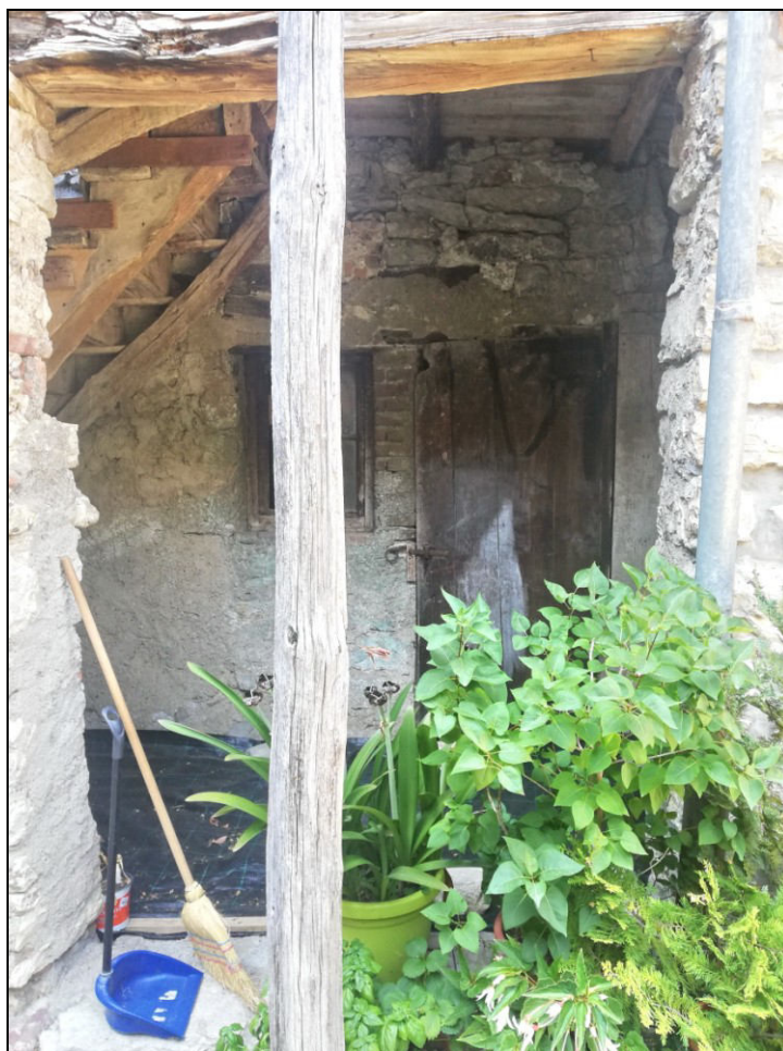
Foto 07 – Portico piano terra
