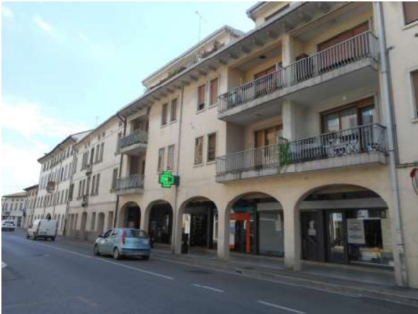
Foto 1 – fronte condominio Via Cavallotti
