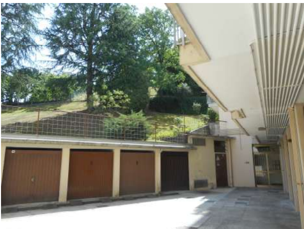
Foto 5 – area scoperta/di manovra
