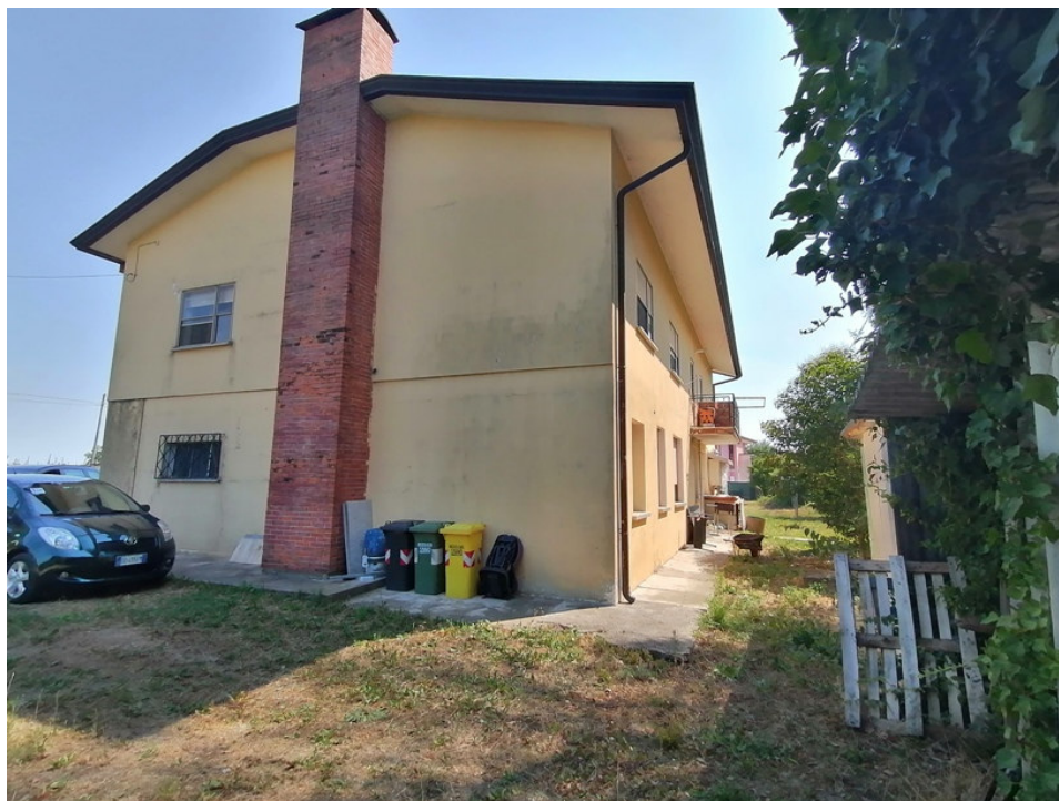
Vista fianco nord fabbricato
