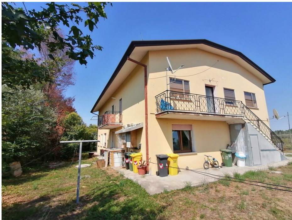
Vista fianco sud fabbricato
