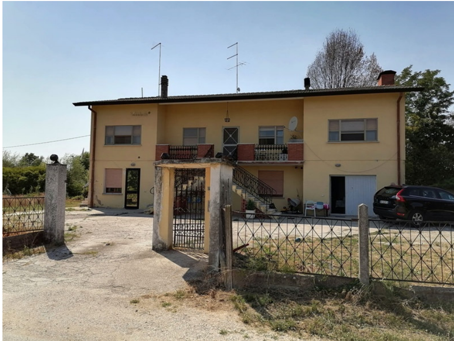
Vista principale fabbricato da Via Fossadelle, con accessi
