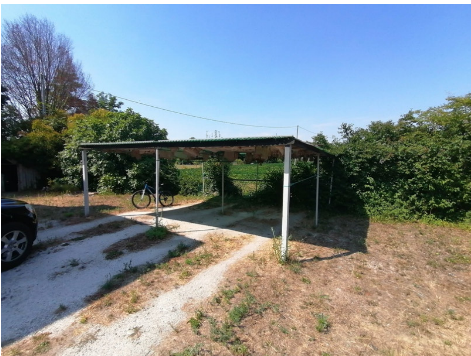
Vista fronte tettoia-posto auto
