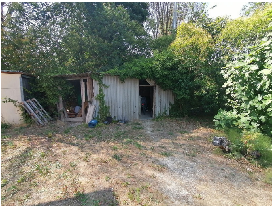
Vista fronte legnaia
