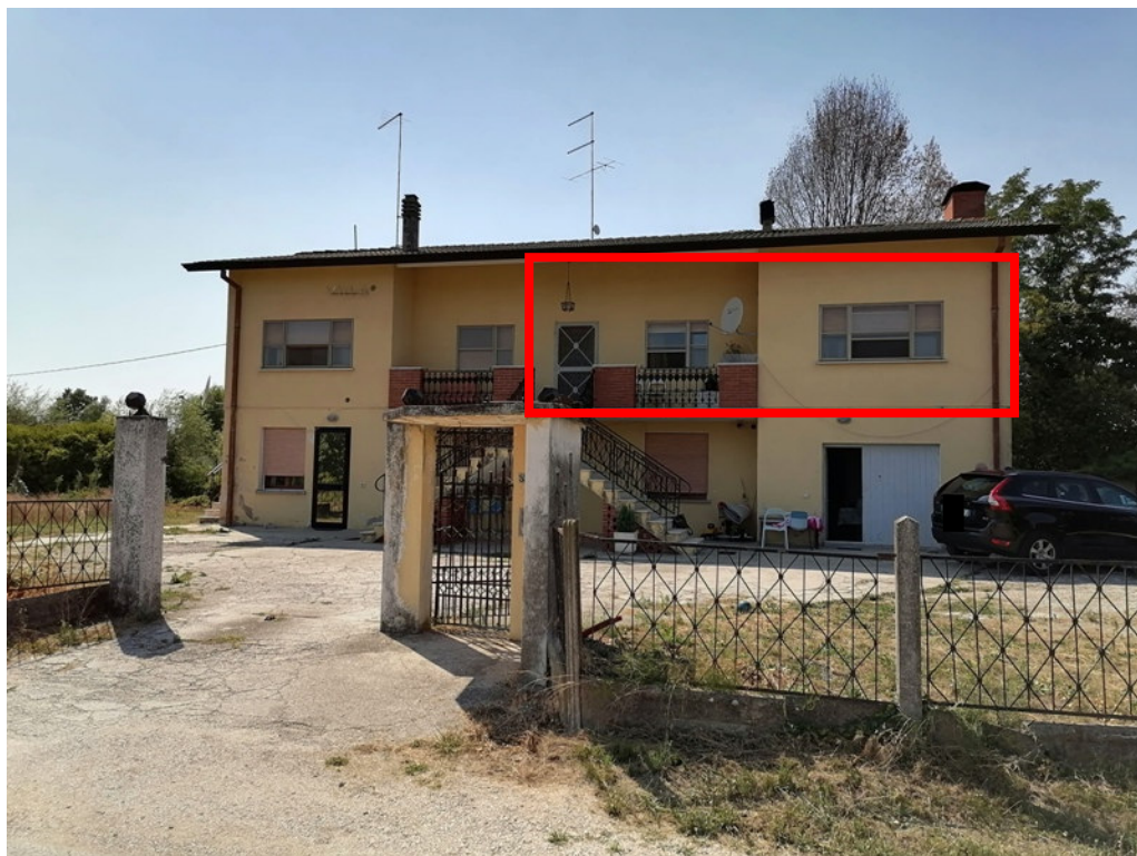
Vista fronte principale fabbricato da Via Fossadelle
