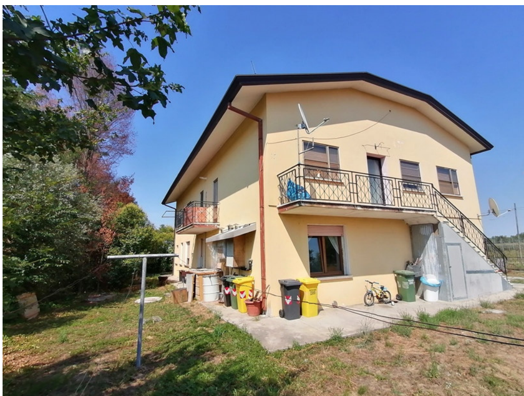
Vista fianco sud e retro fabbricato
