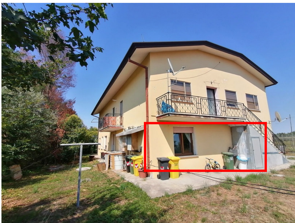
Vista fianco sud (lato "alloggio uno") e retro fabbricato
