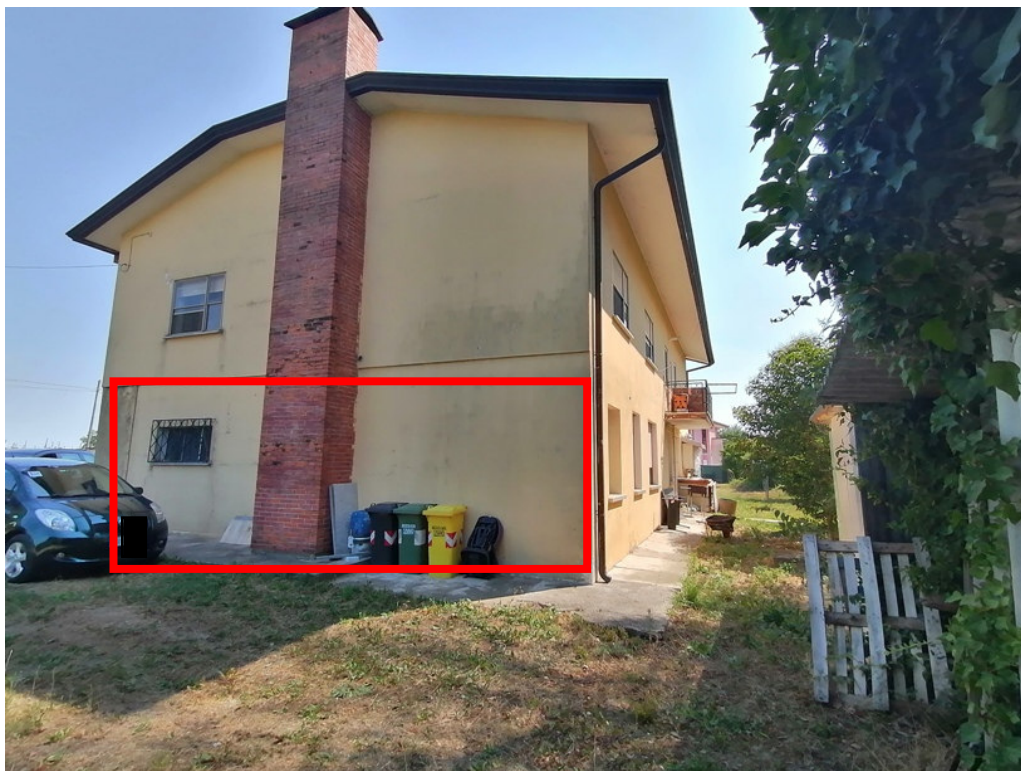
Vista fianco nord del fabbricato (lato alloggio "due")
