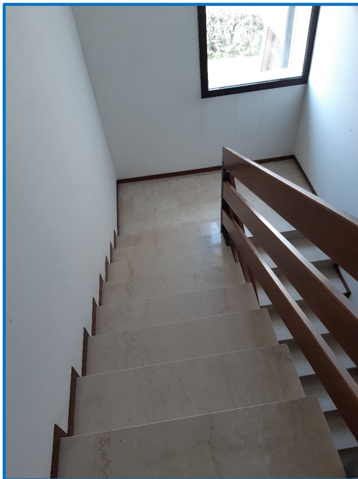
n° 4 Vano scala condominiale
