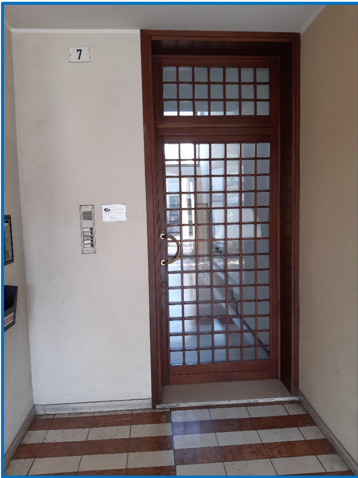
n° 3 Ingresso condominiale
