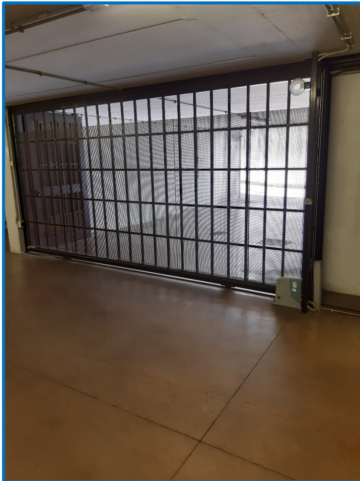
n° 18 – Cancello comune garage
