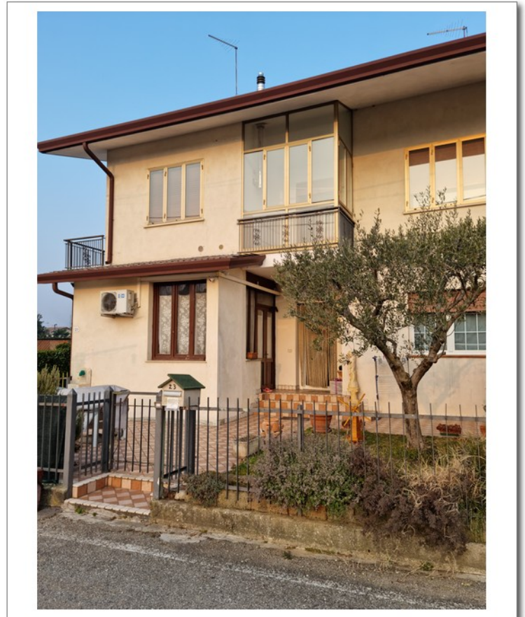
2 Vista sud-est fabbricato
