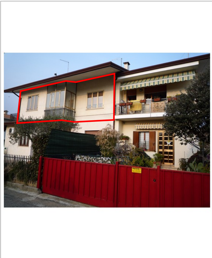
2.1 vista sud-est fabbricato
