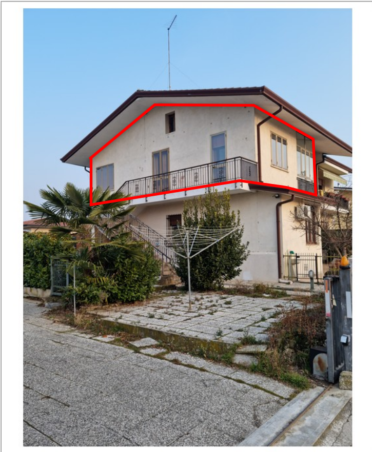
1 Vista sud fabbricato
