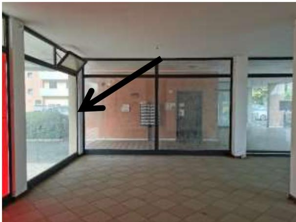
**Foto n. 15** difformità costituita dalle vetrine del lato sud montate in posizione arretrata.
