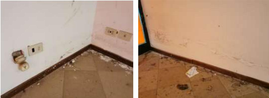
*Foto n. 8 \_ Particolari murature con sforinamento degli intonaci e distacco delle pitture*
