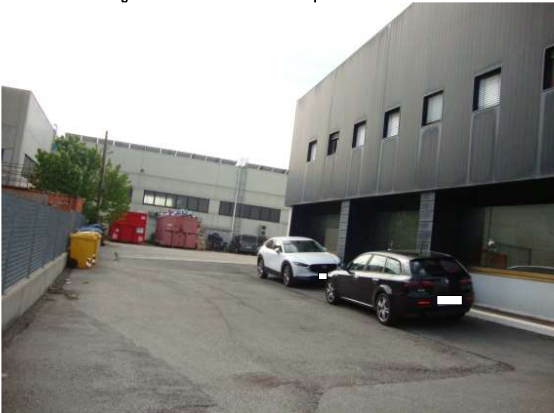
Fig. 2.16 – vista da nord dello scoperto comune lato est
