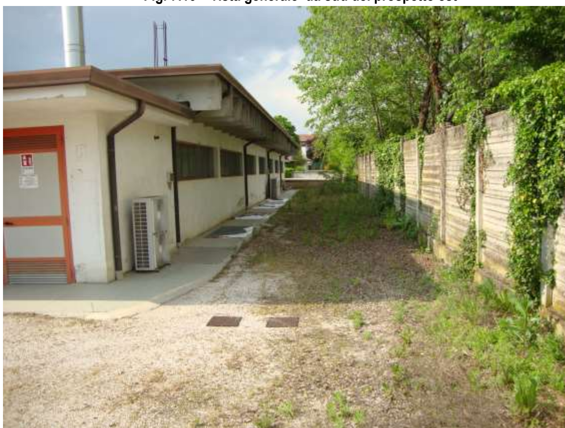
Fig. 7.16 – vista generale da sud del prospetto est
