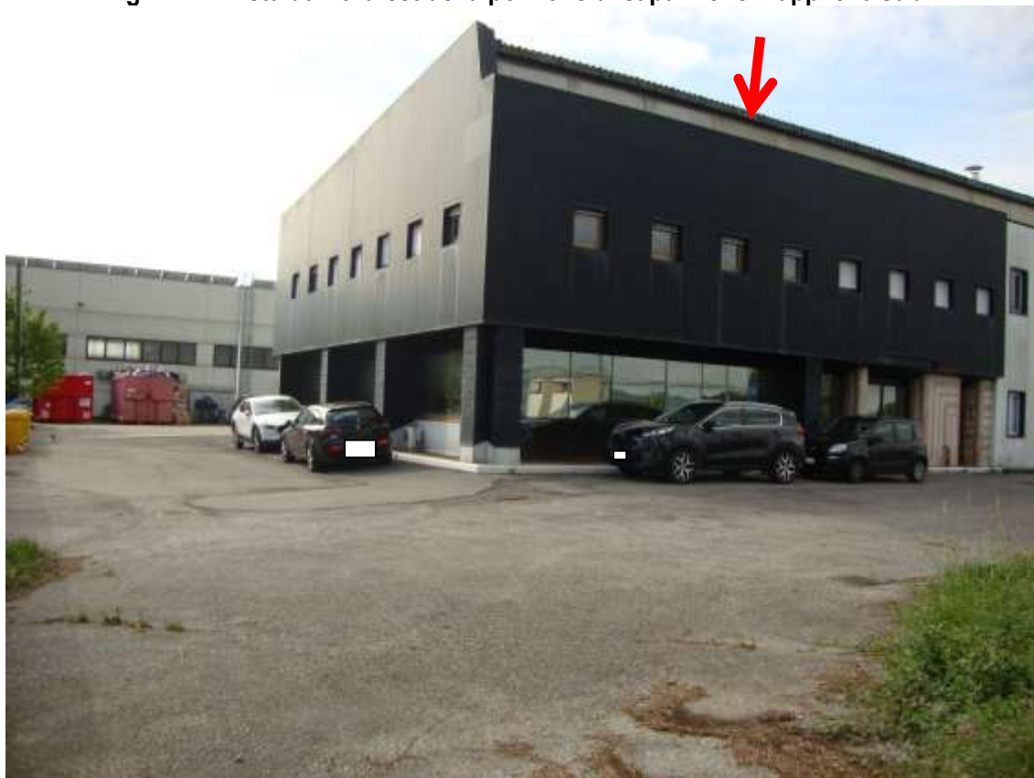
Fig. 2.14 – vista da nord-est della porzione di capannone mapp. 520 sub 7
