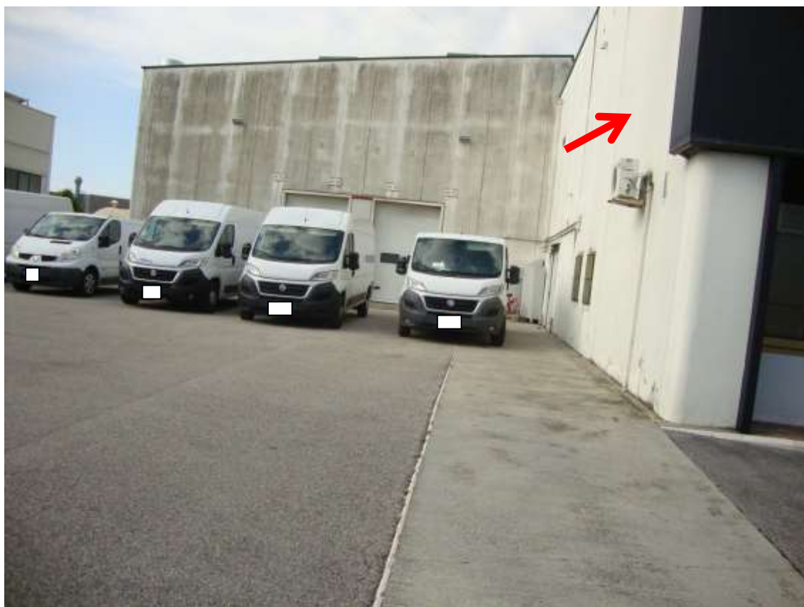
Fig. 2.18 – vista da est della porzione di capannone mapp. 520 sub 7 e dello scoperto comune lato sud
