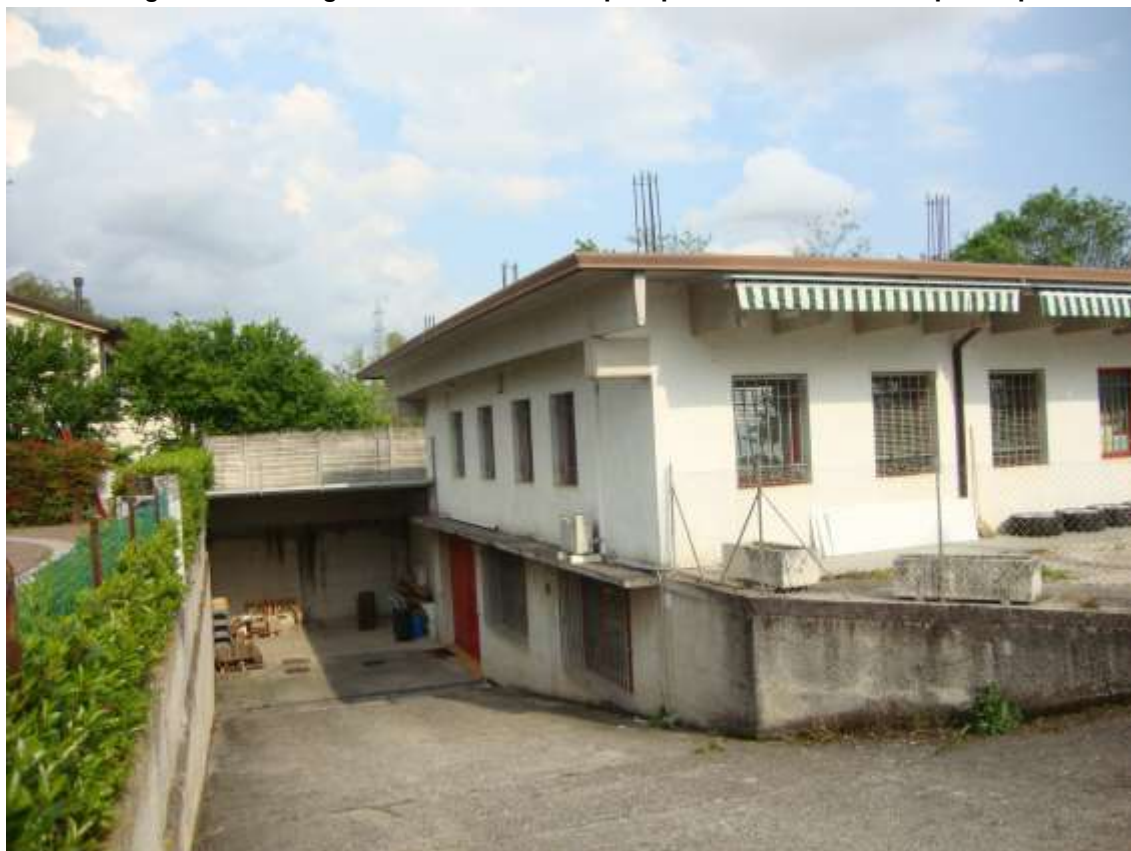
Fig. 7.17 – vista generale da ovest del prospetto nord e della rampa scoperta
