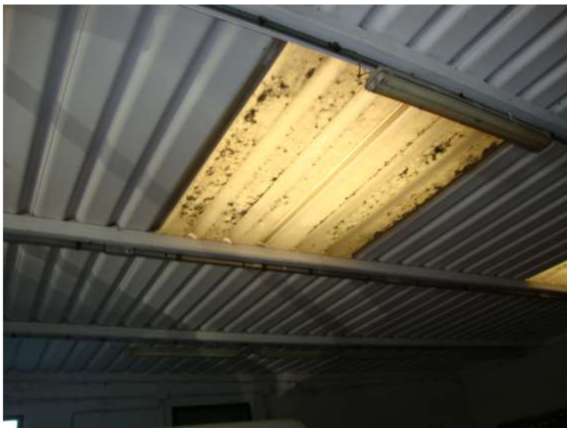
Fig. 4.19 – particolare della copertura
