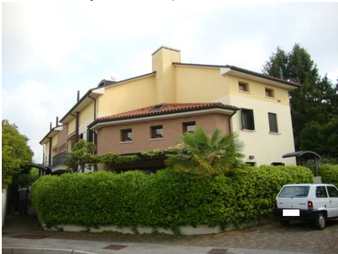
Fig. 9.12 – vista del complesso condominiale da sud
