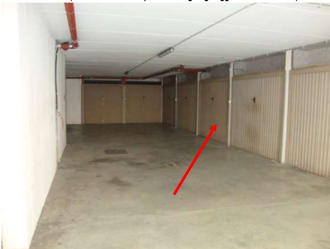
Fig. 5.28 – spazio di manovra coperto interrato condominiale (con freccia rossa il portone del garage oggetto di esecuzione)
