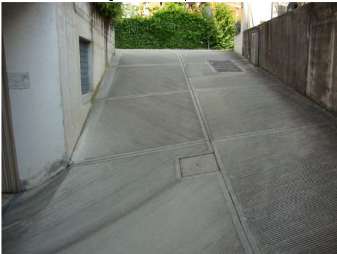
Fig. 5.30 – scivolo scoperto condominiale
