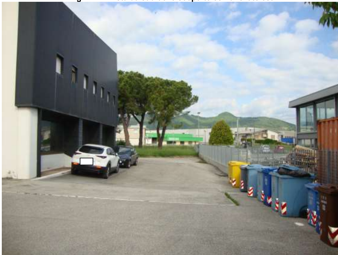
Fig. 1.17 – vista da sud dello scoperto comune lato est
