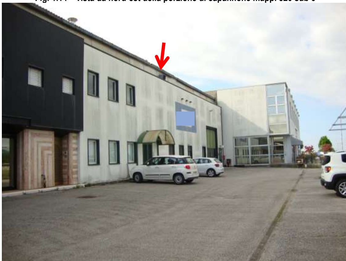
Fig. 1.14 – vista da nord-est della porzione di capannone mapp. 520 sub 6
