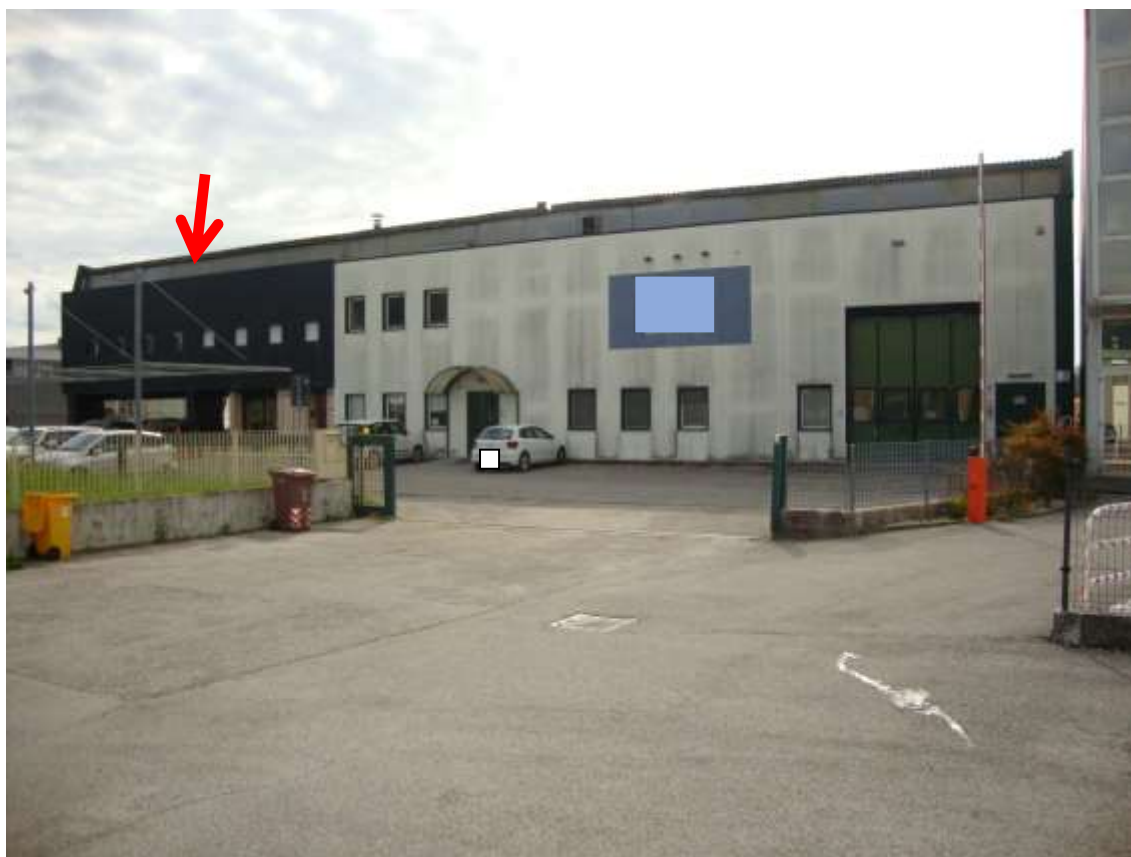
Fig. 2.13 – vista da nord della porzione di capannone mapp. 520 sub 7 e dell'accesso da via Padova (S.P. n. 667)
