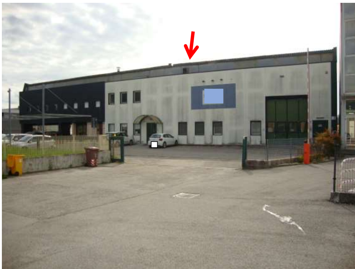
Fig. 1.13 – vista da nord della porzione di capannone mapp. 520 sub 6 e dell'accesso da via Padova (S.P. n. 667)
