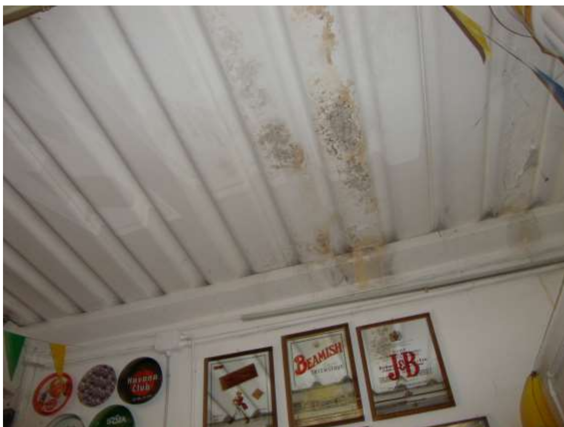
Fig. 4.18 – particolare della copertura
