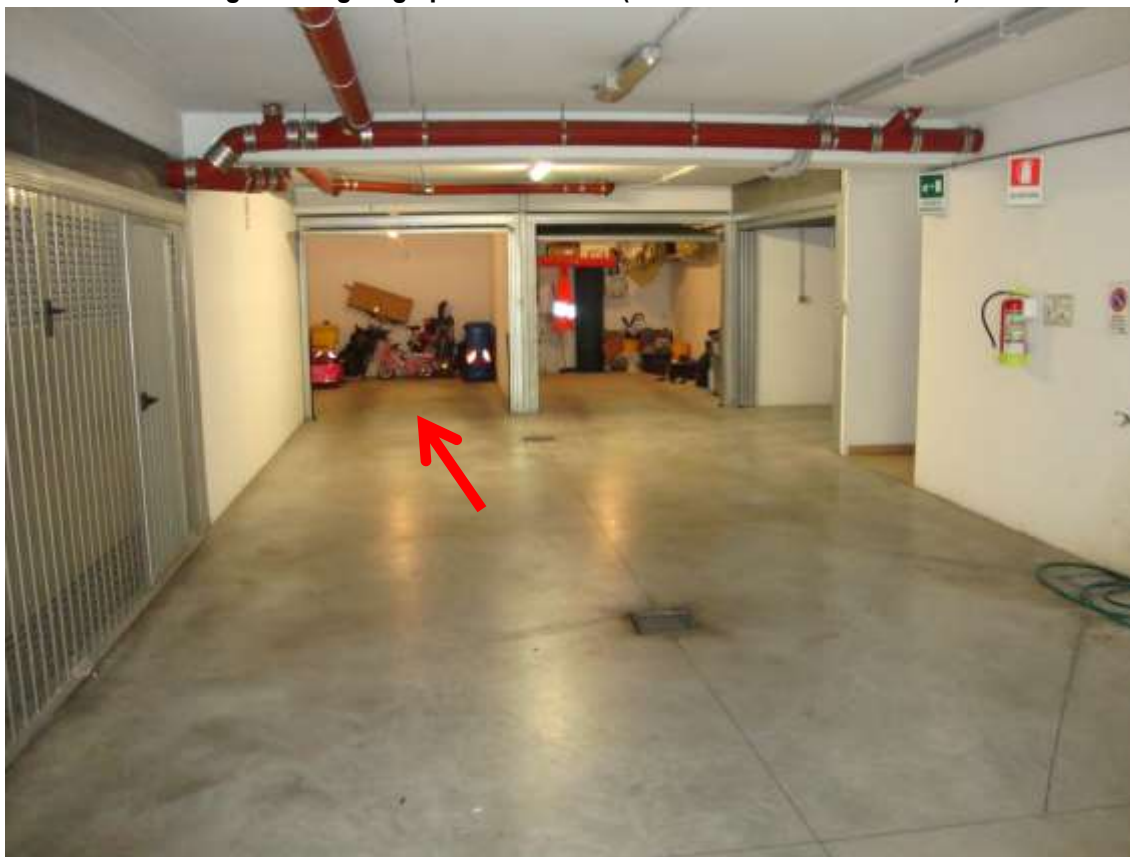
Fig. 9.31 – garage piano interrato (indicato con freccia rossa)
