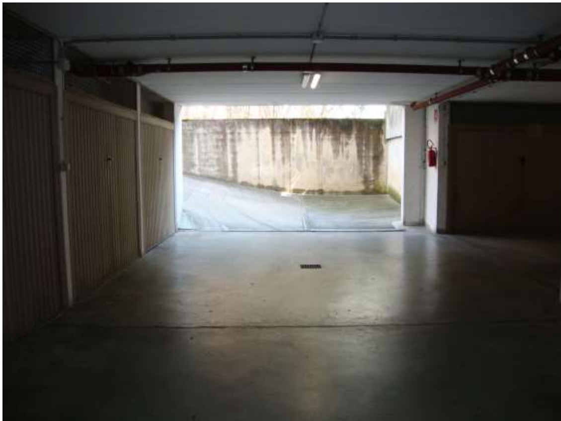
Fig. 5.29 – accesso dalla rampa dello spazio di manovra coperto interrato condominiale
