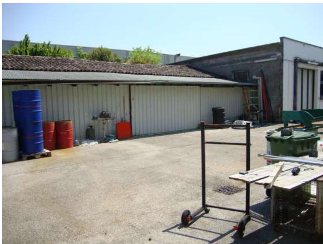
Fig. 4.24 – tettoia abusivamente realizzata a nord del fabbricato (DA DEMOLIRE)
