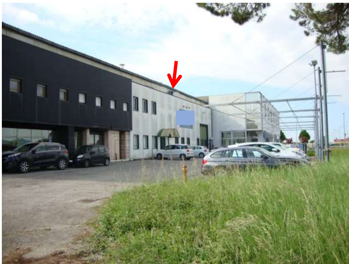
Fig. 1.15 – vista da nord- est della porzione di capannone mapp. 520 sub 6 e dello scoperto comune lato nord
