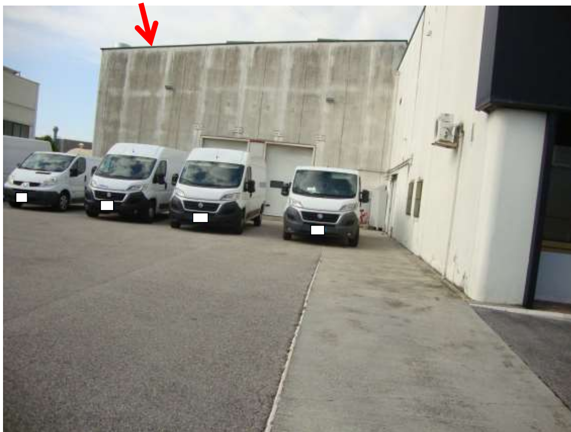
Fig. 1.18 – vista da est della porzione di capannone mapp. 520 sub 6 e dello scoperto comune lato est
