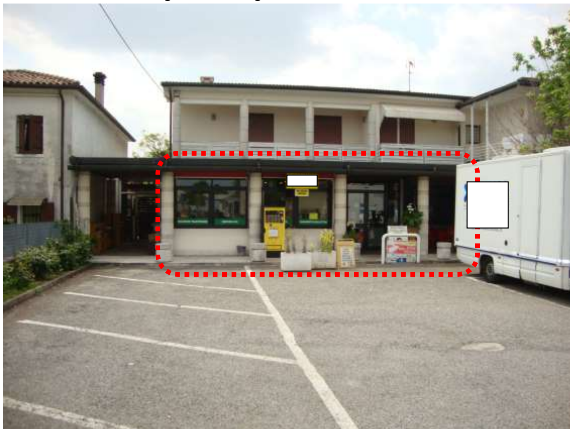
Fig. 6.11 – vista generale del fabbricato da nord
