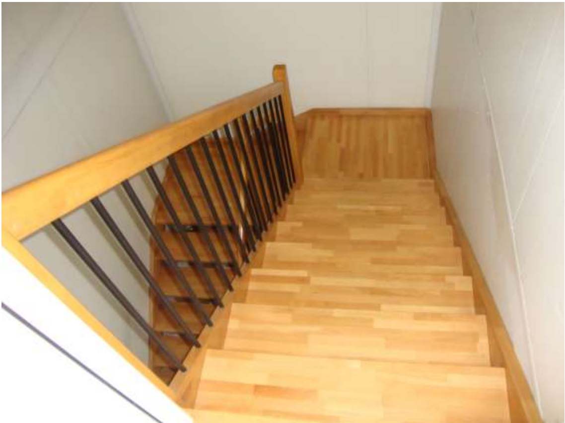
Fig. 1.23 – particolare scala interna per l'accesso all'ufficio piano primo
