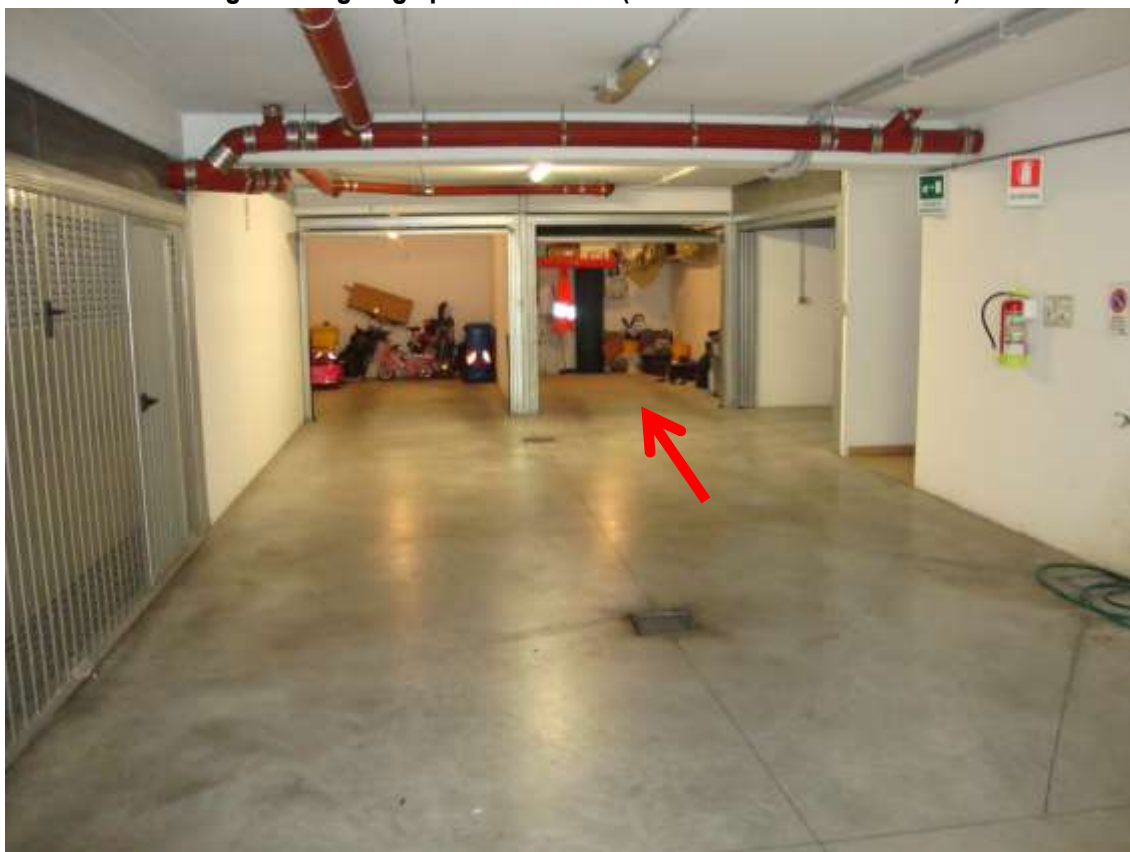
Fig. 8.26 – garage piano interrato (indicato con freccia rossa)
