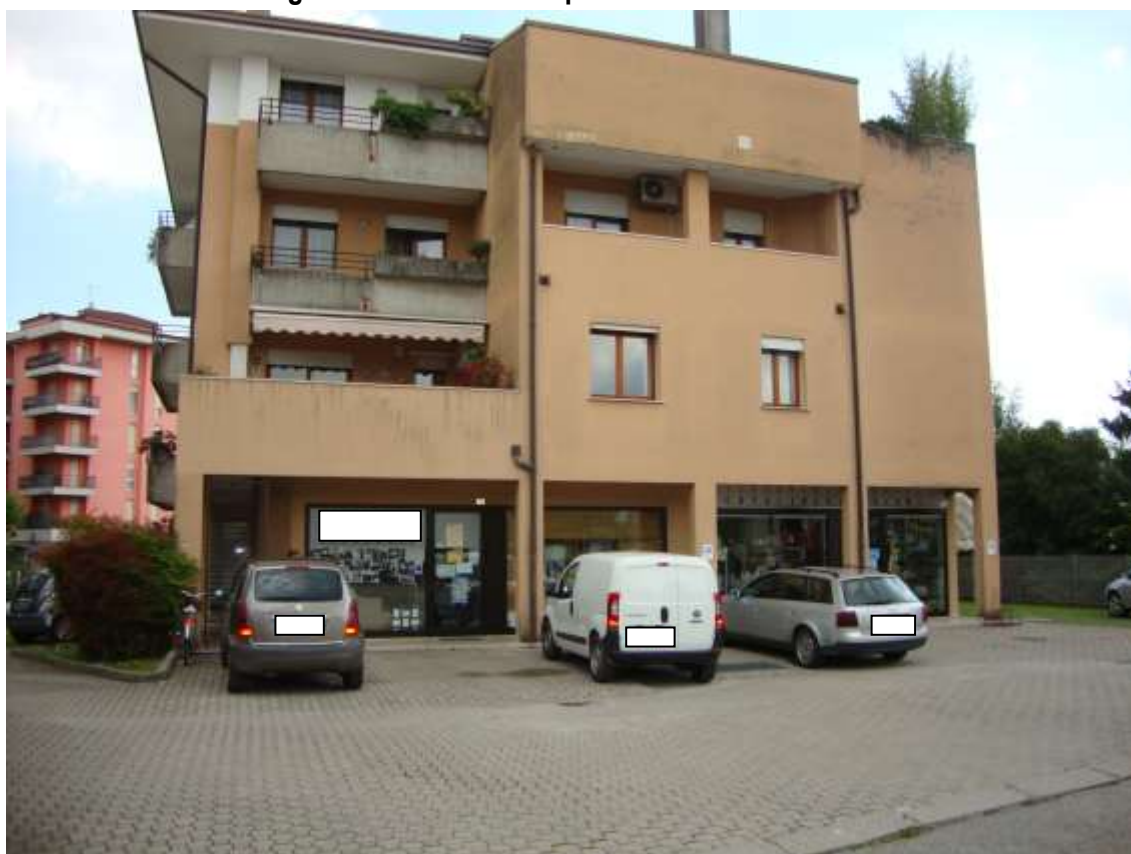
Fig. 5.12 – vista del complesso condominiale da ovest
