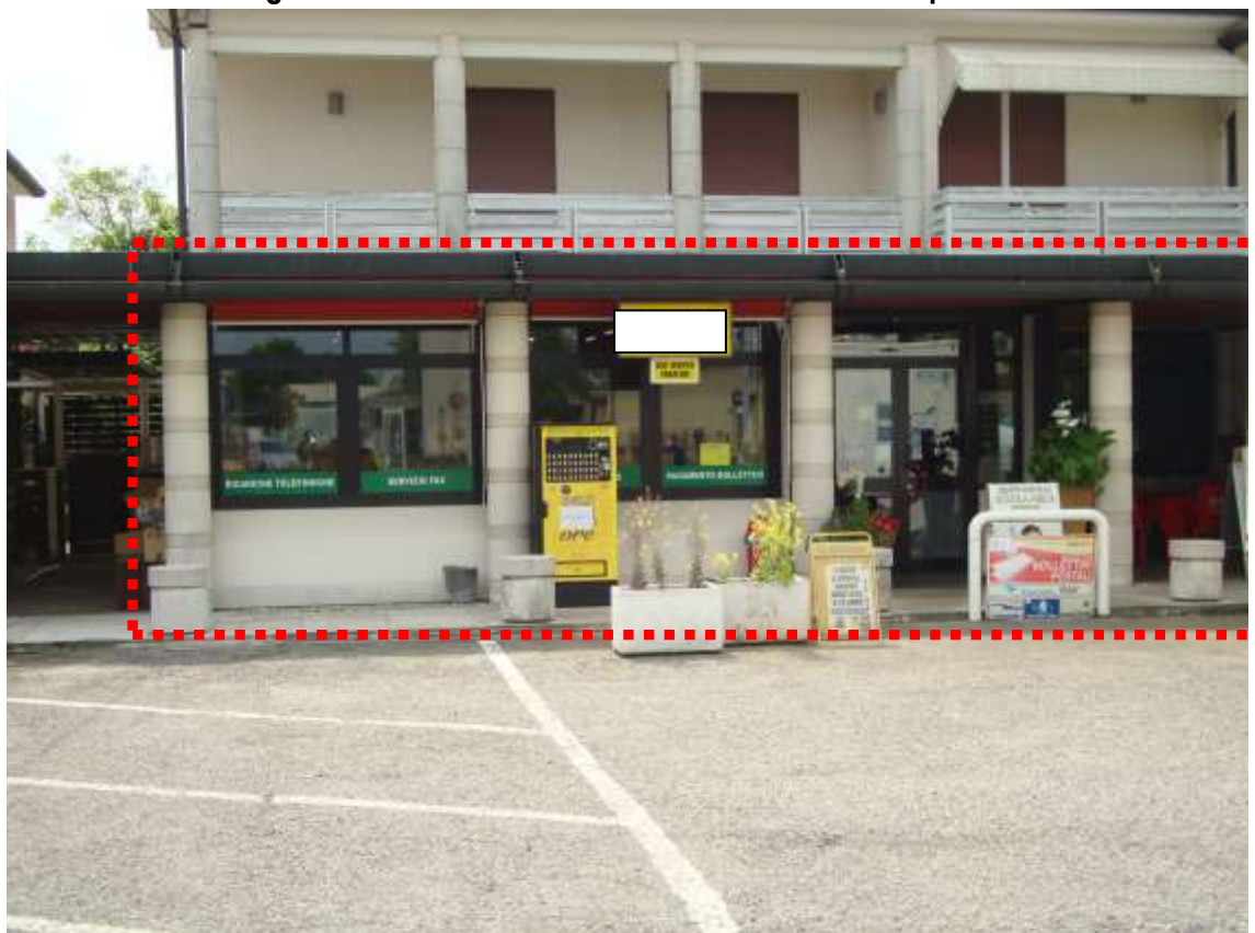
Fig. 6.12 – vista da nord del locale commerciale al piano terra
