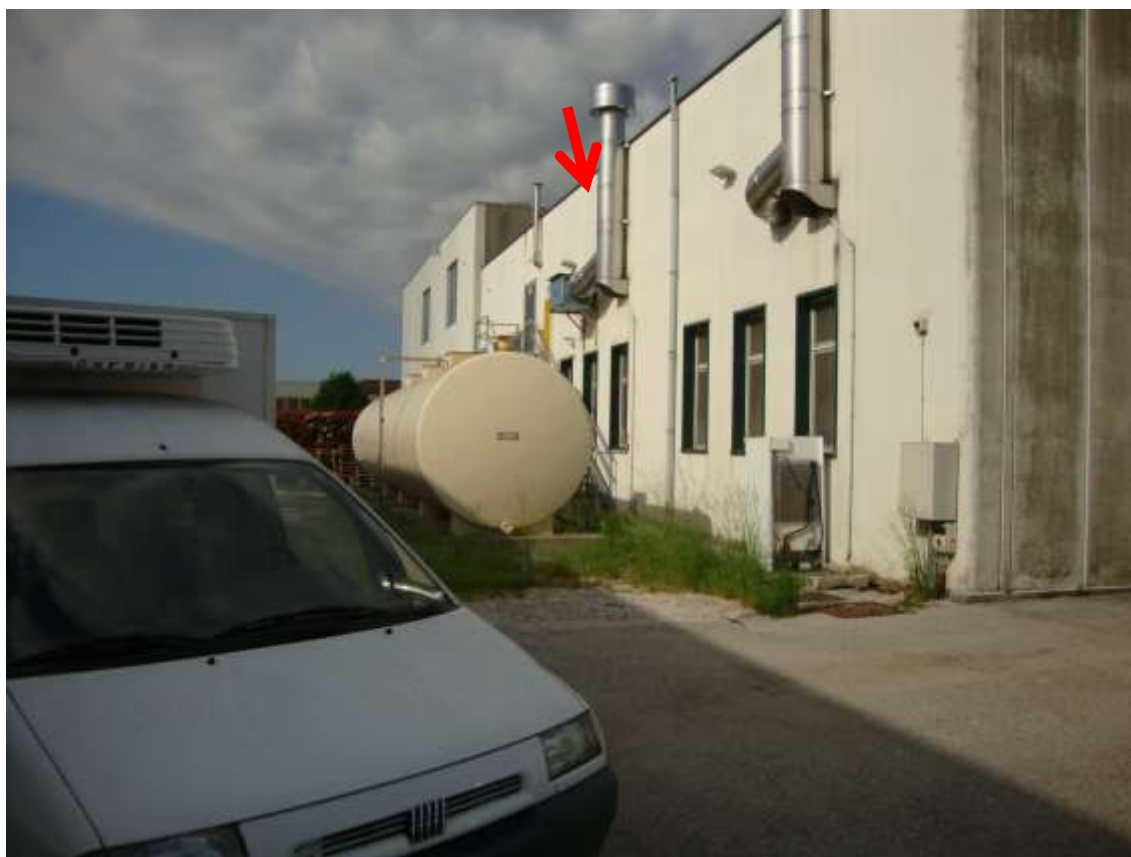
Fig. 1.19 – vista da sud-est della porzione di capannone mapp. 520 sub 6 e dello scoperto comune lato sud
