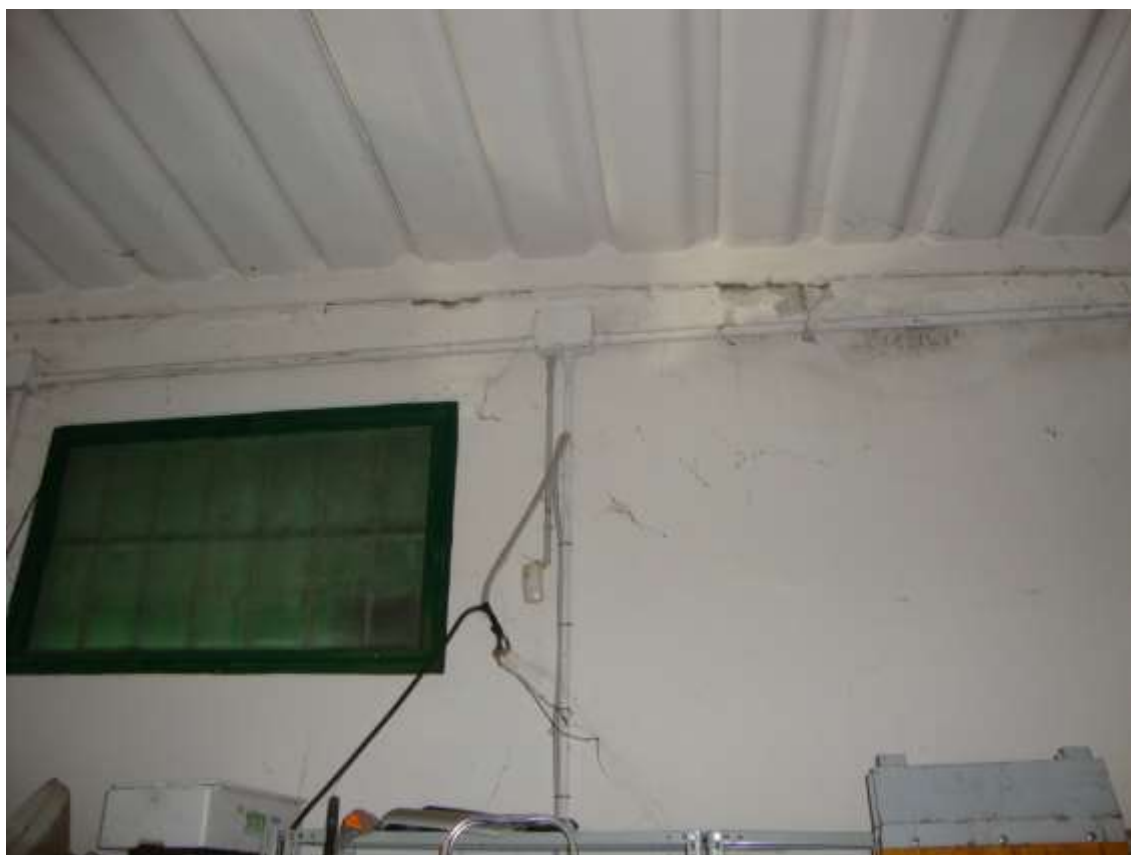
Fig. 4.20 – particolare della copertura
