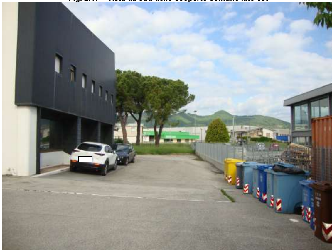
Fig. 2.17 – vista da sud dello scoperto comune lato est
