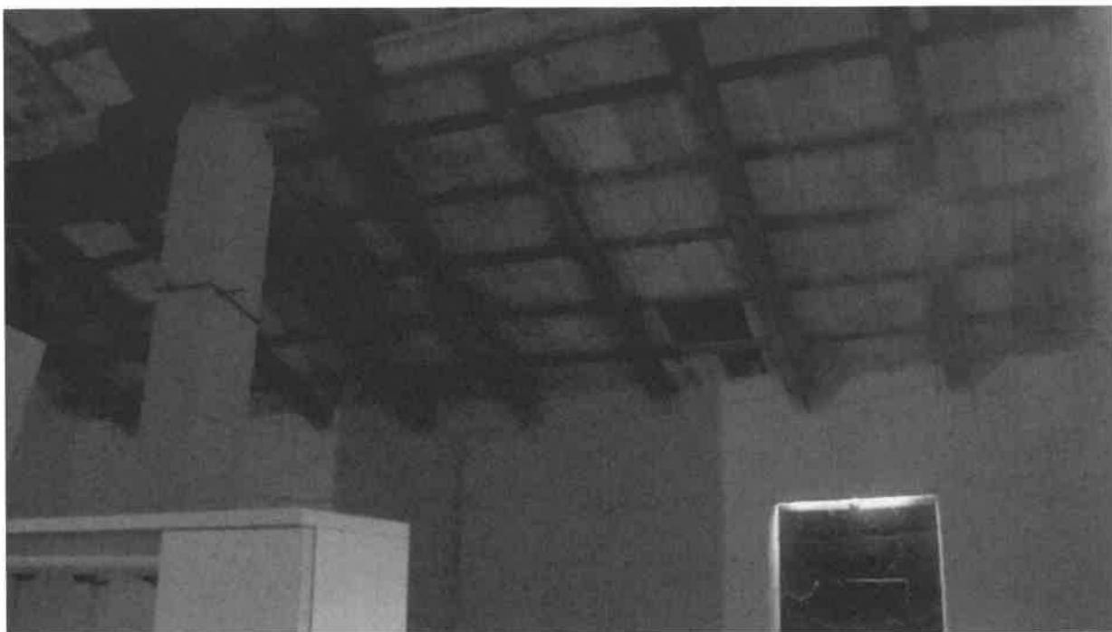
Fotografia 23: il soffitto del piano secondo
