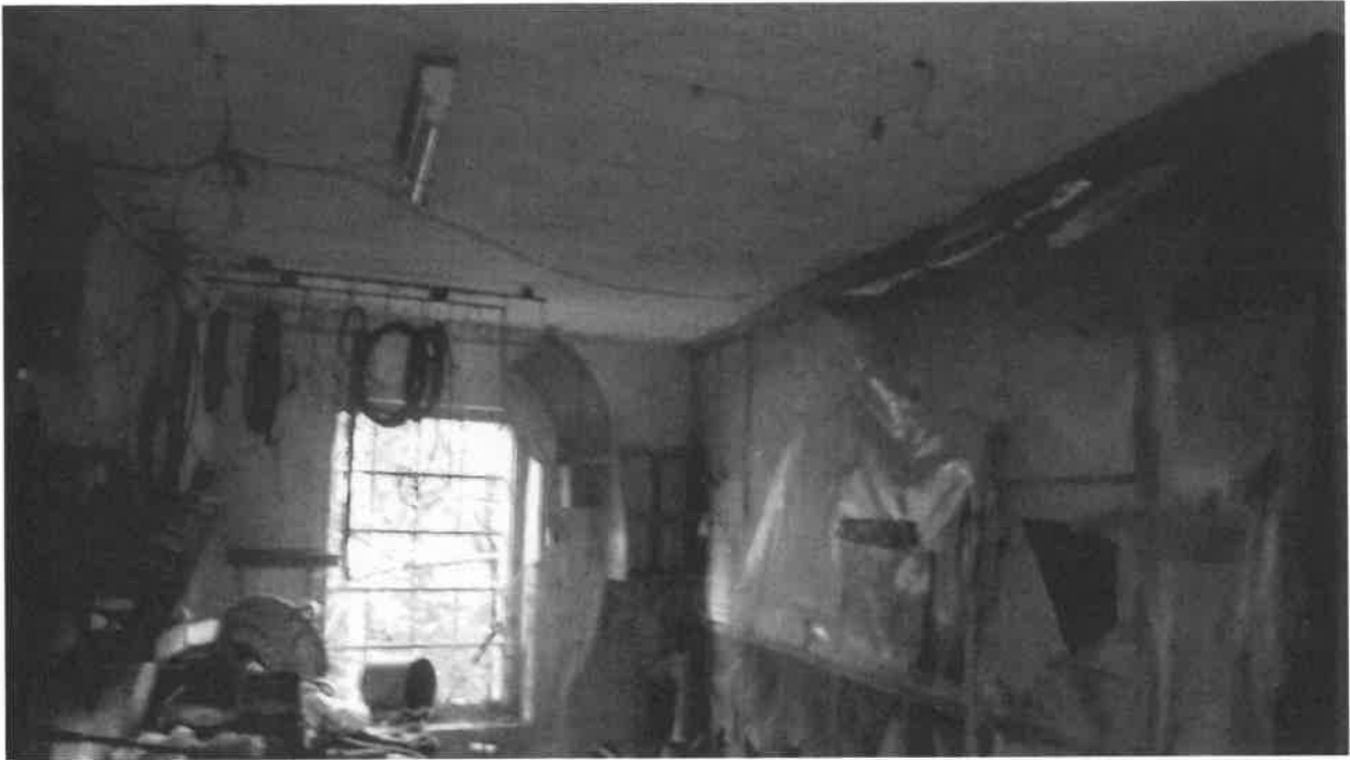
Fotografia 39: il magazzino del sub. 4 visto da nord
