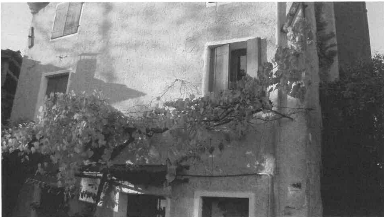
Fotografia 7: il fronte (sud) - parte intermedia - del sub. 2
