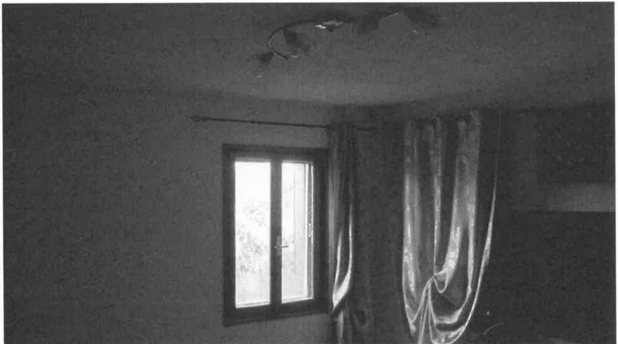
Fotografia 18: la camera a nord est
