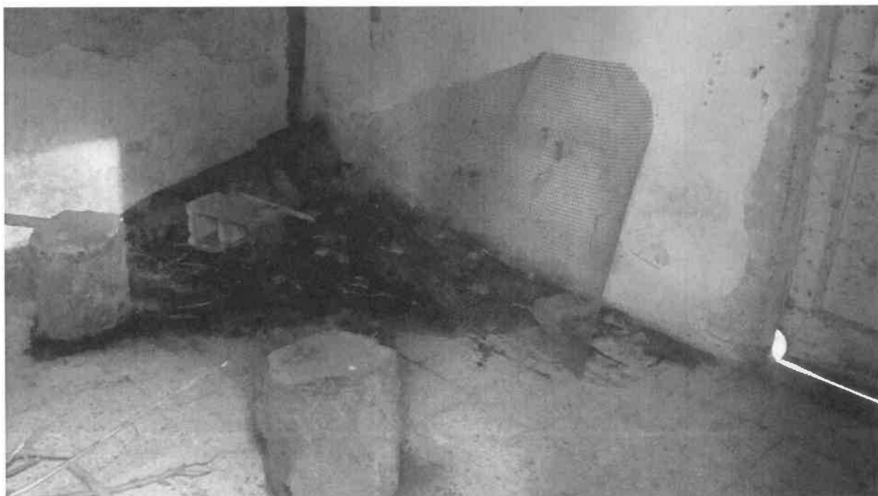
Fotografia 32: il bagno lavanderia del sub. 3
