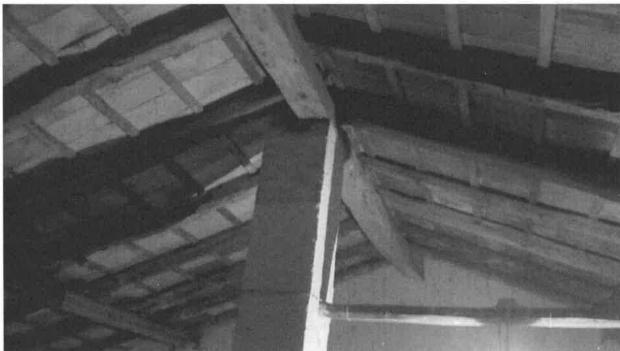
Fotografia 26: la struttura del tetto del piano secondo
