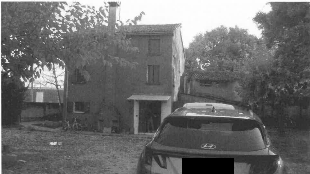
Fotografia 14: il fronte nord del fabbricato con l'ingresso ad altra proprietà
