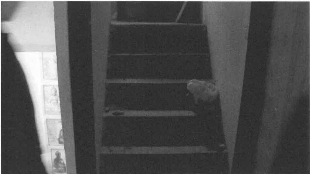
Fotografia 22: la scala di accesso al piano secondo
