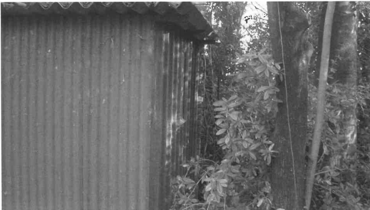
Fotografia 35: la baracca abusiva del sub. 4 - particolare
