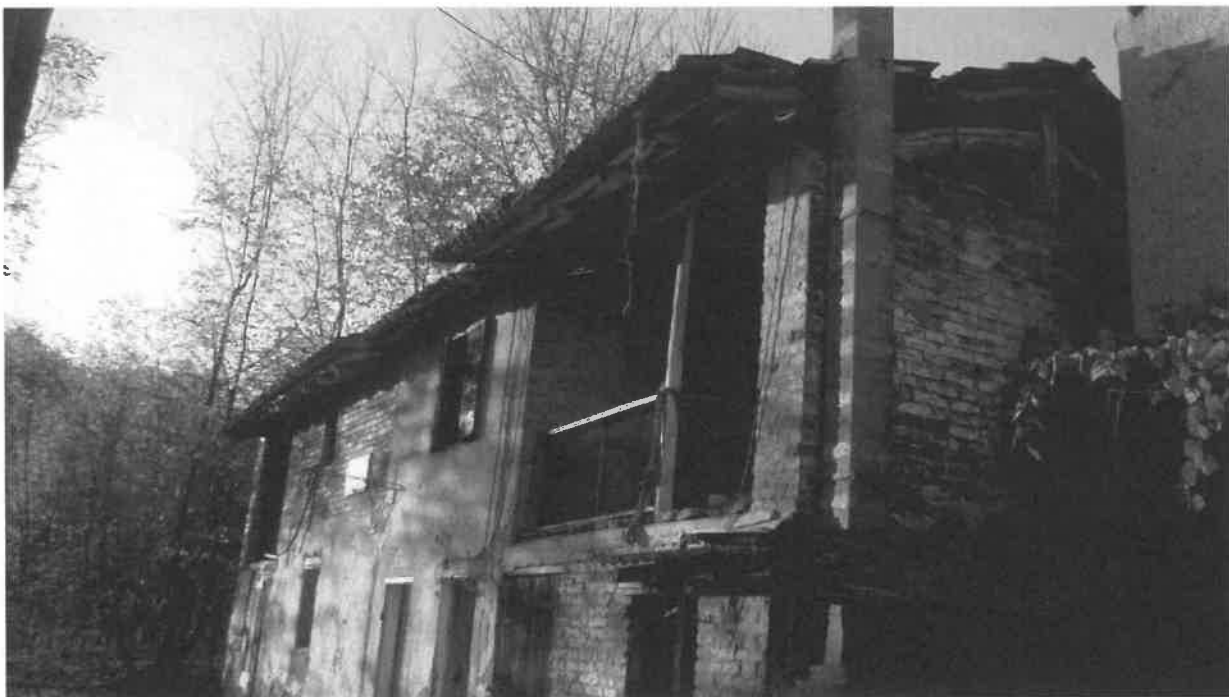
Fotografia 27: il fronte sud, parte alta, del sub. 3, visto da sud-est
