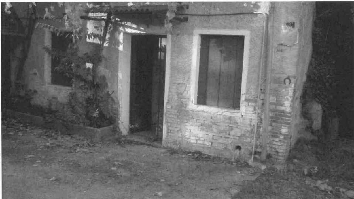
Fotografia 8: il fronte (sud) - parte bassa - ingresso del sub. 2
