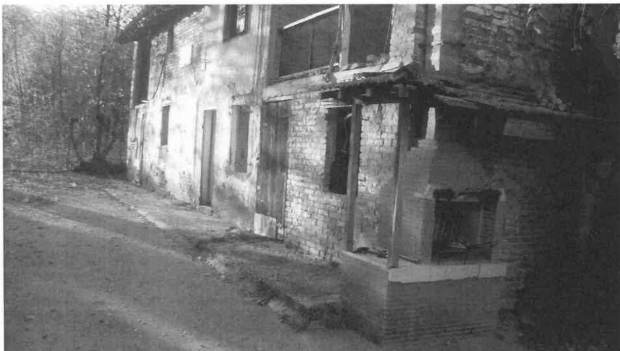
Fotografia 28: il fronte sud, parte bassa, del sub. 3, visto da sud-est
