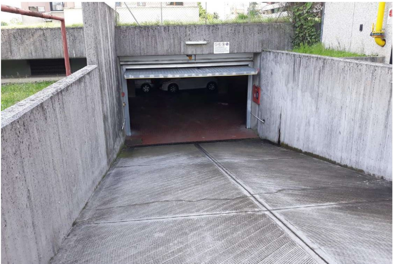
Foto 4 – Accesso carraio e rampa condominiale
