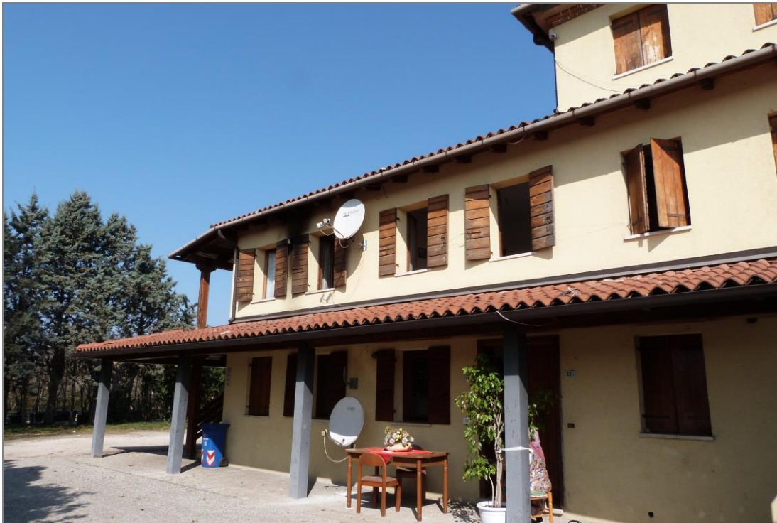
3 Vista da sud-est di parte del prospetto sud (fronte strada) del fabbricato di cui fa parte l'unità immobiliare oggetto di esecuzione.
