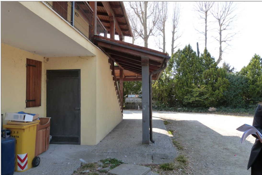
4 Vista di parte del prospetto ovest con l'accesso al sottoscala comune adibito a ripostiglio e di parte del porticato e dell'area scoperta comune.
