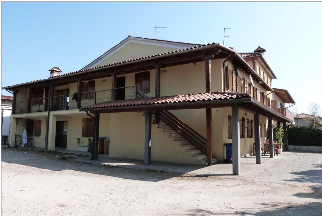
2 Vista dall'area scoperta comune dei prospetti ovest e sud del fabbricato di cui fa parte l'unità immobiliare oggetto di esecuzione. Si notano il porticato, la scala esterna e la veranda comuni.
