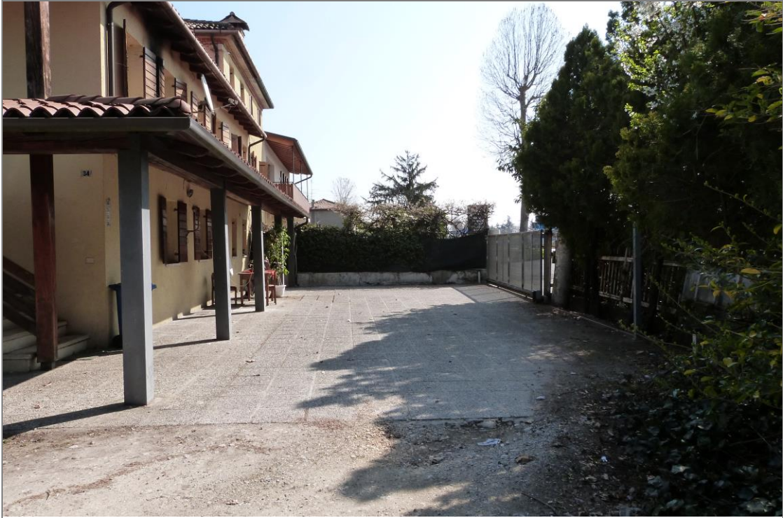
13 Vista di parte dell'area scoperta a sud e del cancello di accesso.
