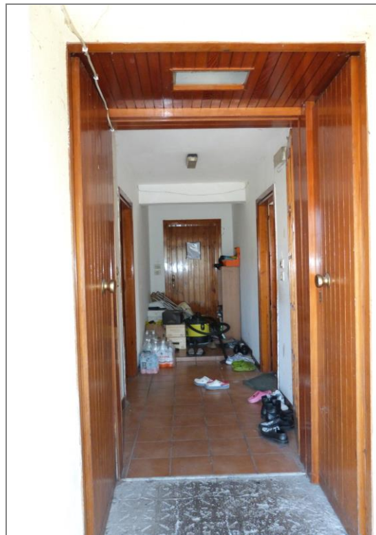
6 Vista dell'ingresso comune al piano primo.
