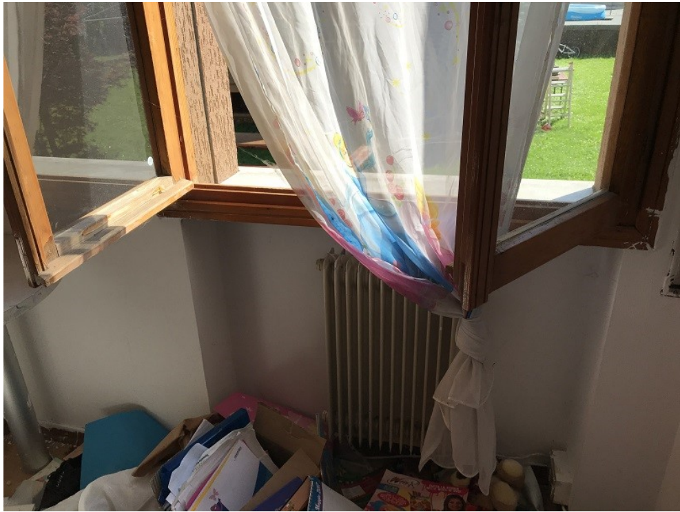
FOTO 18 – particolare serramenti e accessori
