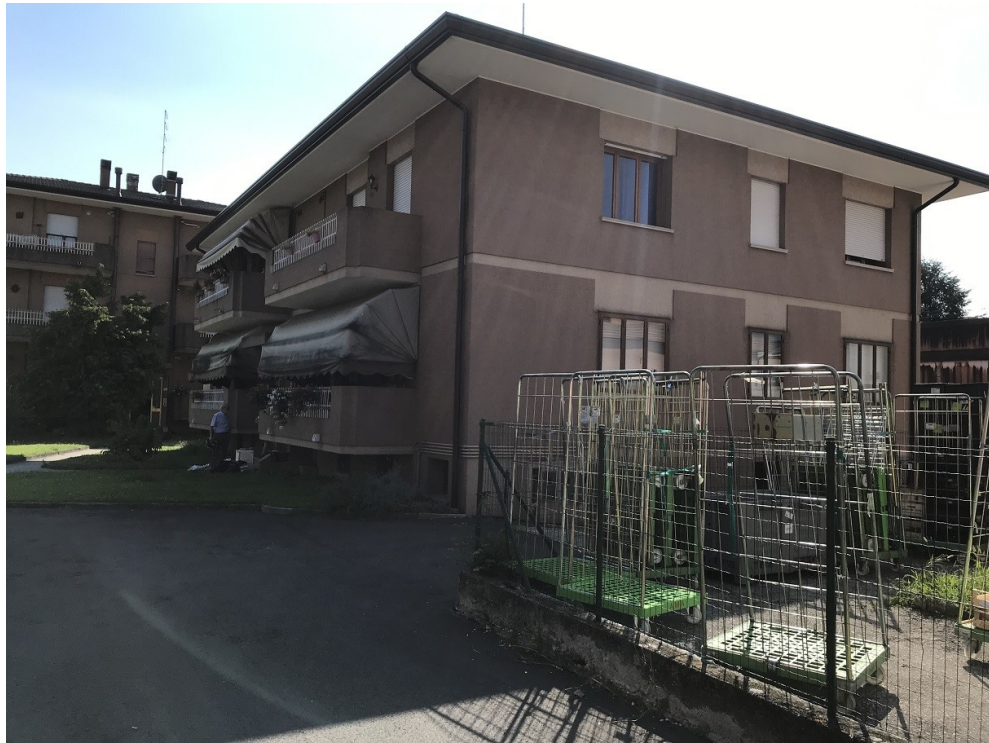
FOTO 4 - accesso da strada pubblica
