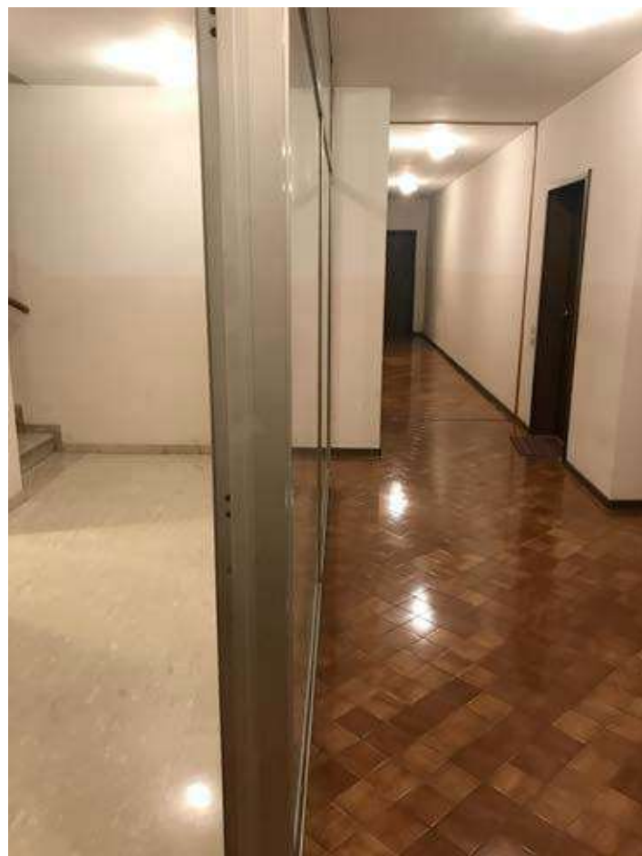
FOTO 10:_Corridoio di distribuzione agli appartamenti_
