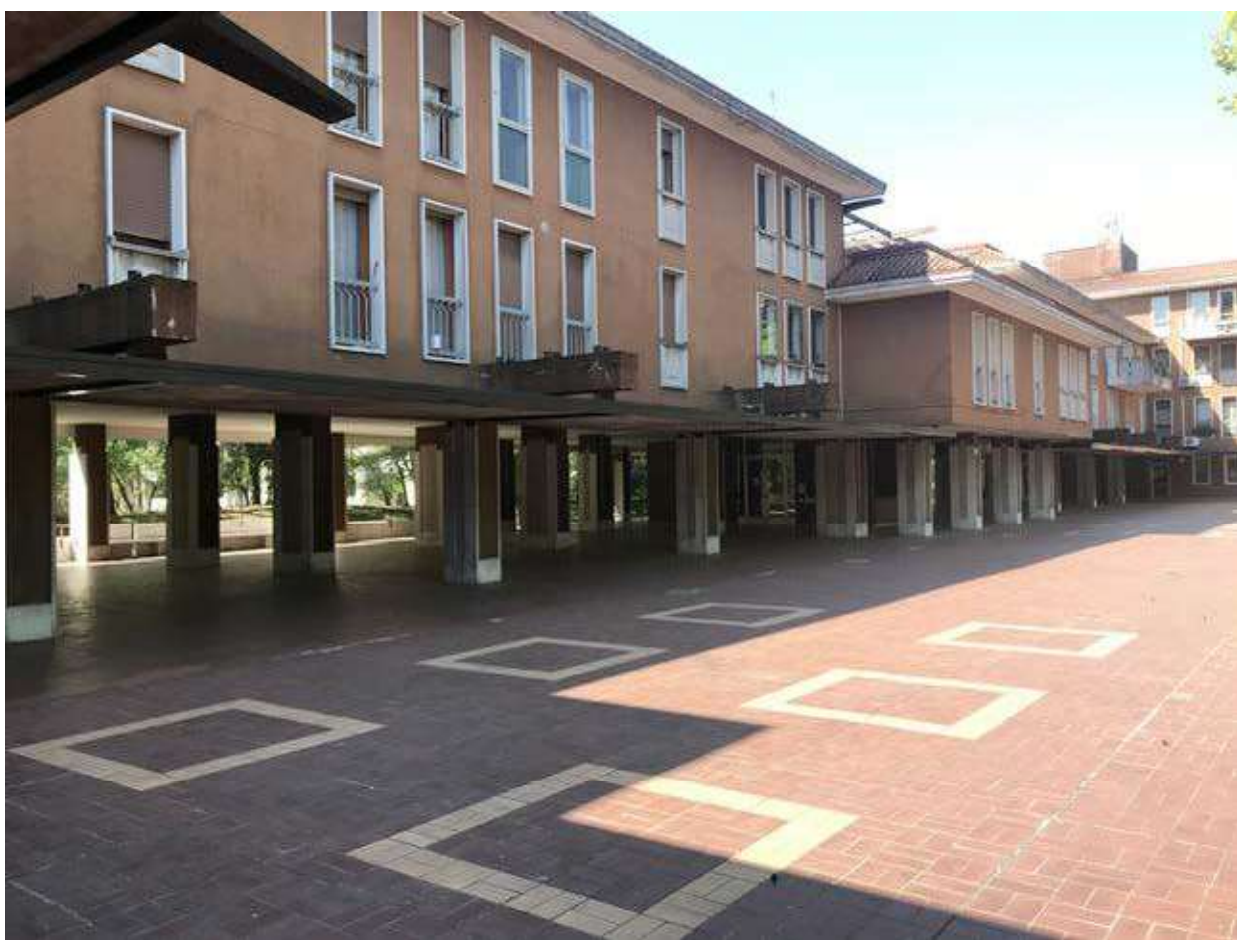
FOTO 7_Corte comune_piano terra
