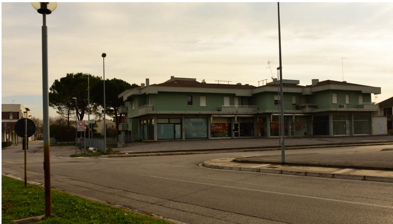
Foto 1- Condominio "Venezia" – Prospetto Nord
