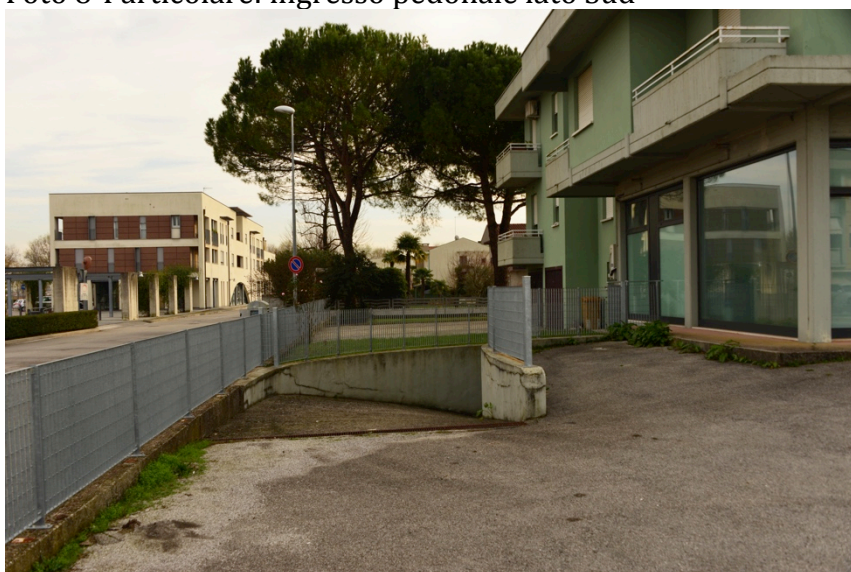
Foto 9-Rampa di accesso al magazzino- Mapp. 279 sub 26
