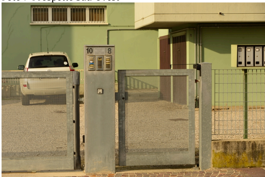
Foto 8-Particolare: ingresso pedonale lato Sud
