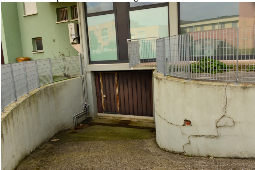
Foto 11-Portone di accesso al Magazzino
