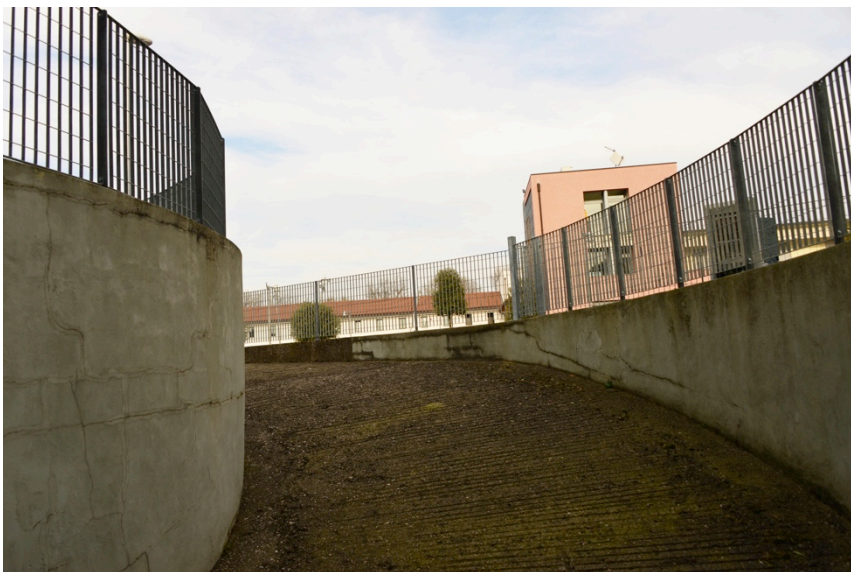
Foto 10- Rampa di accesso al magazzino
