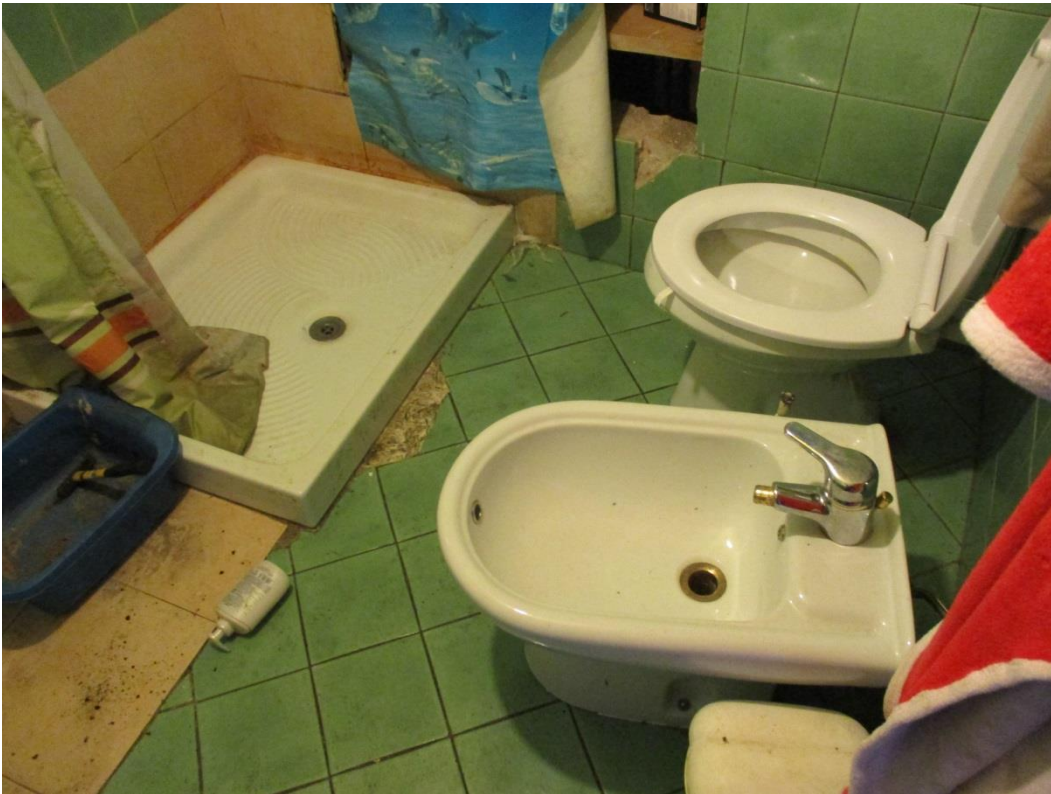
Fatiscenza elementi sanitari e finiture - inadeguatezza altezza e mancanza di aerazione
