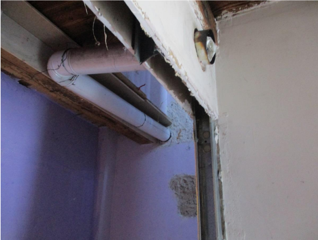
Scarico fumi aderente a travature in legno
