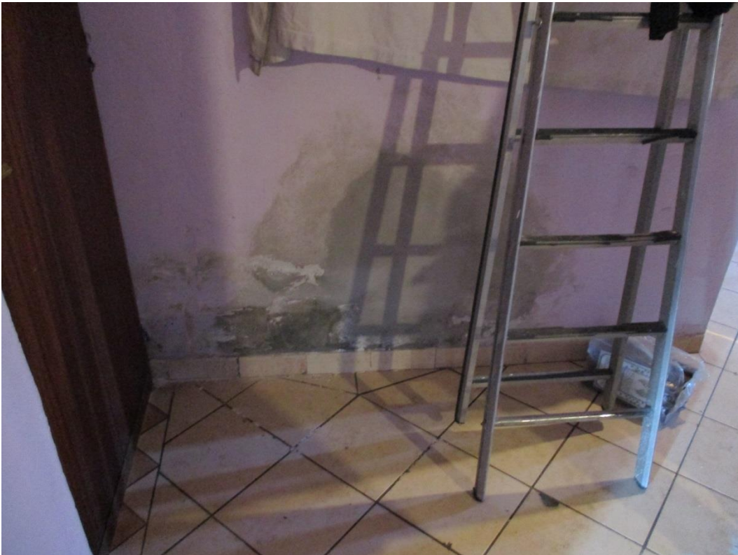
Umidità di risalita perdite scarichi/tubazioni – bagno
