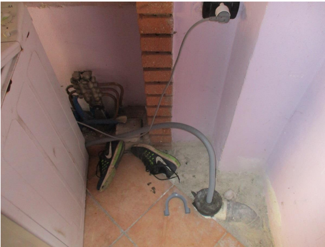
Scarichi e collettori predisposizione impianto riscaldamento in vista – atrio a nord
