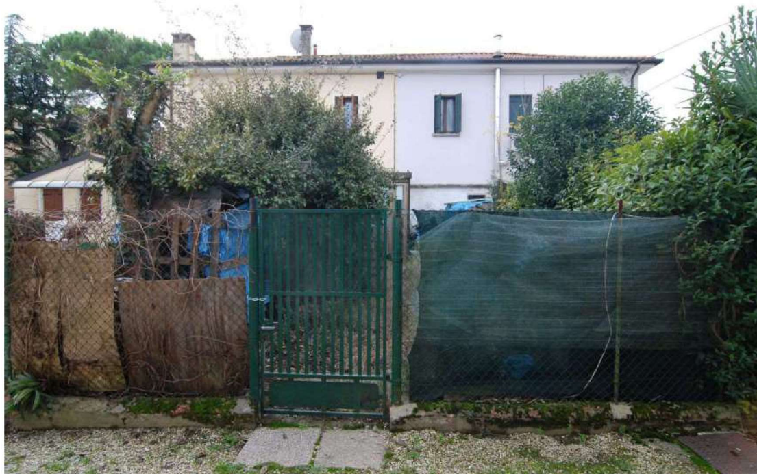
Vista da accesso da mappale n. 1120
