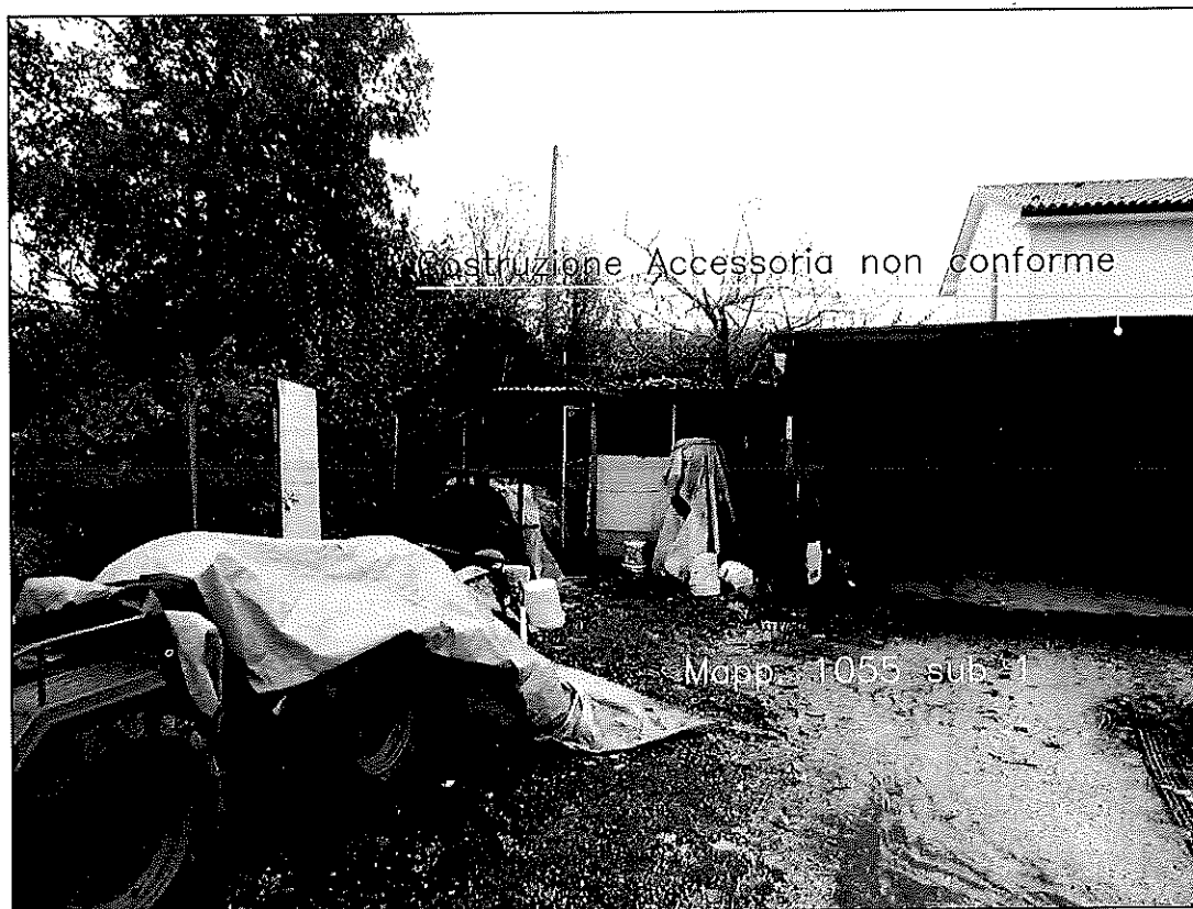
PARTICOLARE COSTRUZIONE ACCESSORIA NON CONFORME COSTRUITA IN PROSSIMITA' DELLO SPIGOLO TRA LATO DI SUD-EST E NORD-EST
