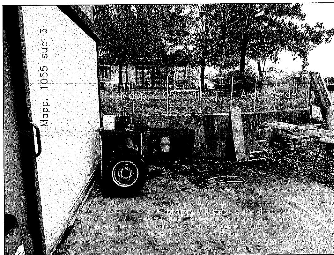
PARTICOLARE PORTONE SCORREVOLE D'ACCESSO AL CAPANNONE
