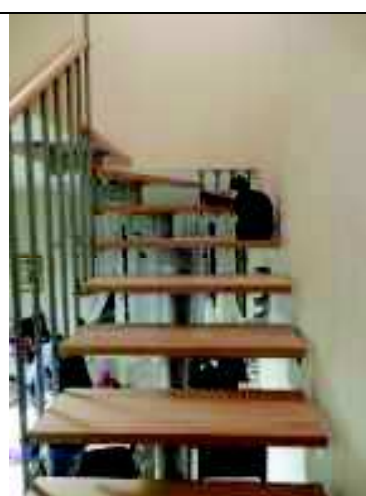
Foto 14 – scala accesso piano 2 – seconda rampa
