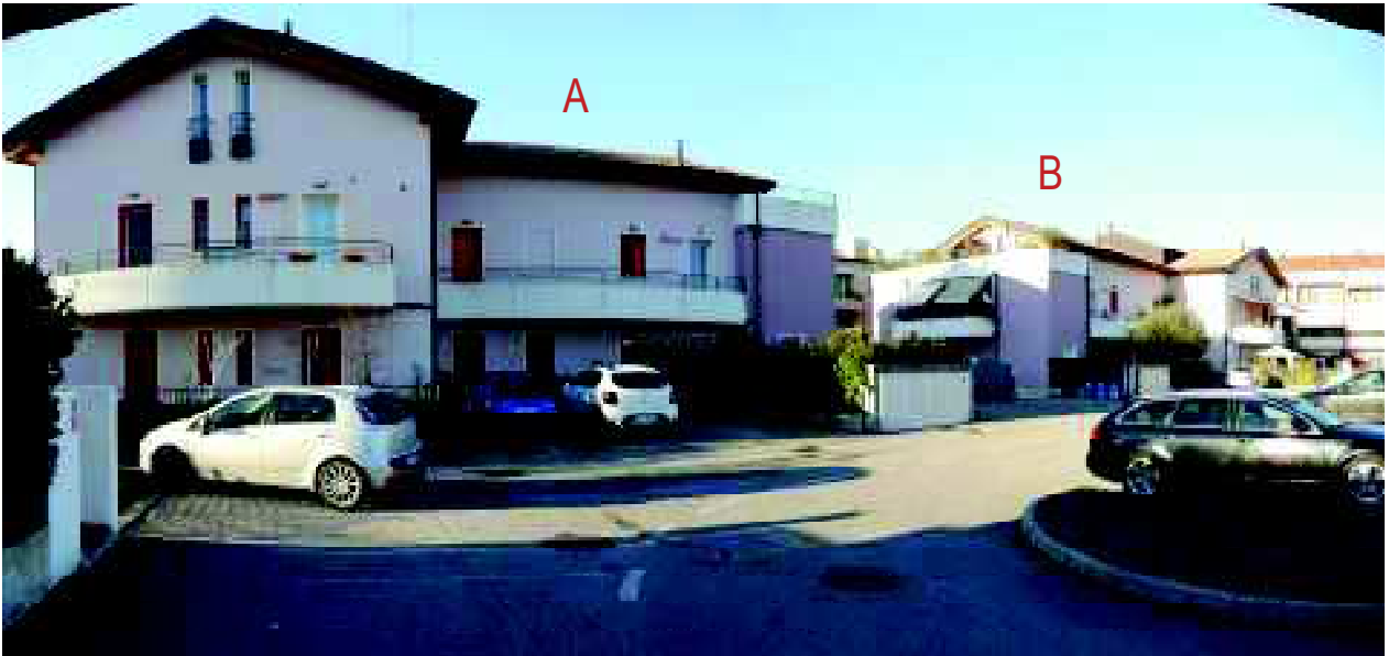
foto 1 - blocco "A" e blocco "B"
