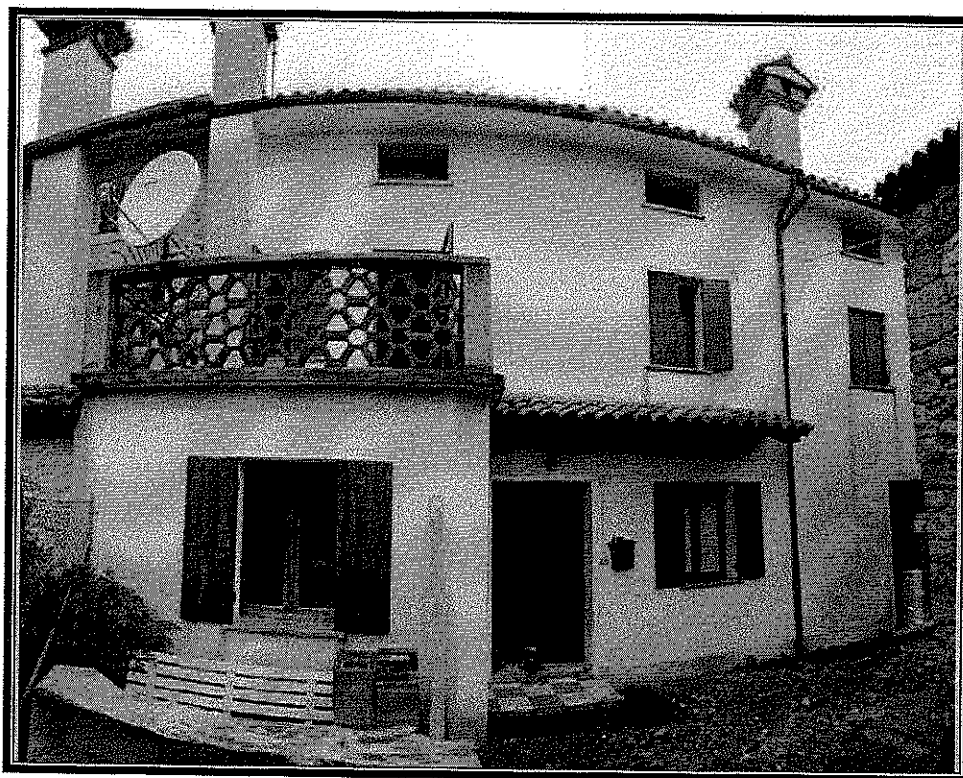
FOTO n.01 – Prospetto Sud - Abitazione
