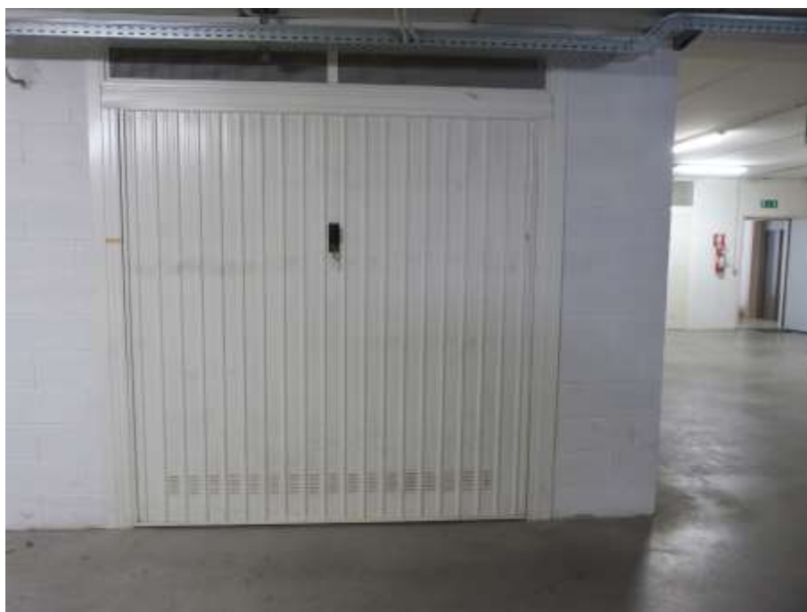
12 Garage piano interrato.
