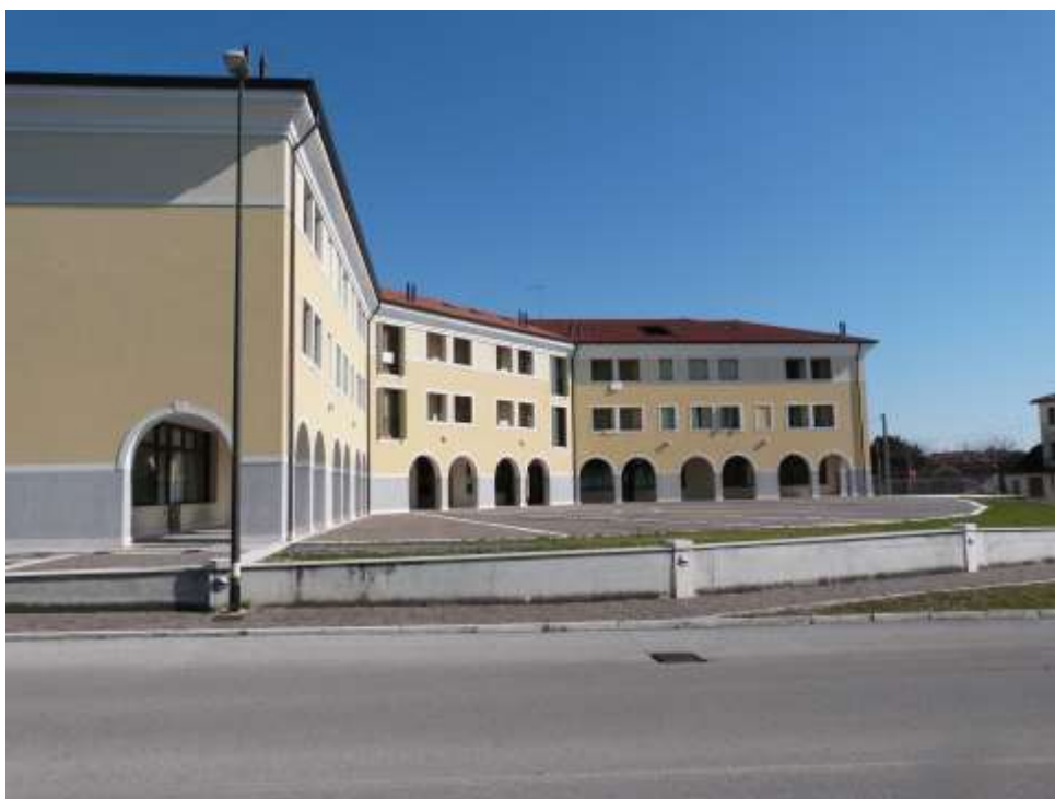
1 Vista dell'immobile da Via Modena – Fronte principale.
