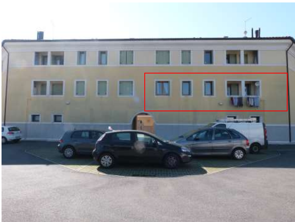
2 Vista del fronte da Via Venezia.
