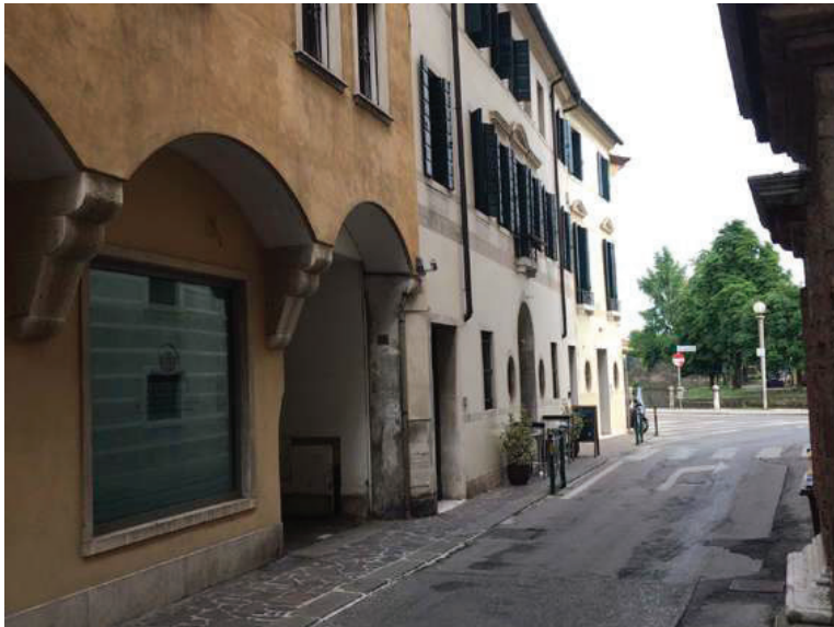
4 – Vista dell'accesso da via Gualpertino da Coderta
