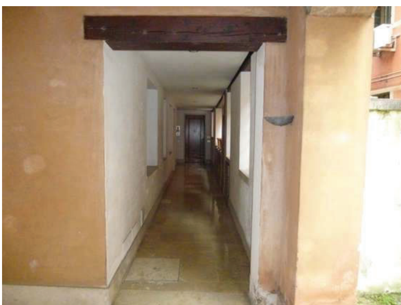
12 – Vista del corridoio condominiale di ingresso al piano terra
