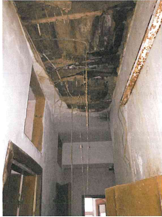
FOTO 6 - PARTICOLARE DEL SOLAIO
