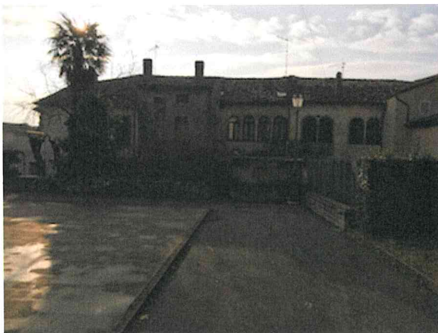
FOTO 4 - LA FACCIA NORD E IL PIAZZALE CONFINANTE
