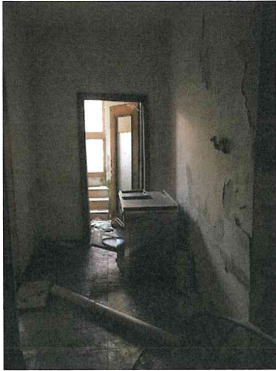
FOTO 5 - L'INGRESSO E IL CORRIDOIO
