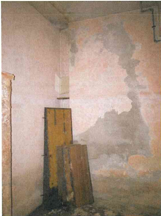
FOTO 7 - GLI AMBIENTI DEL PIANO TERRA
