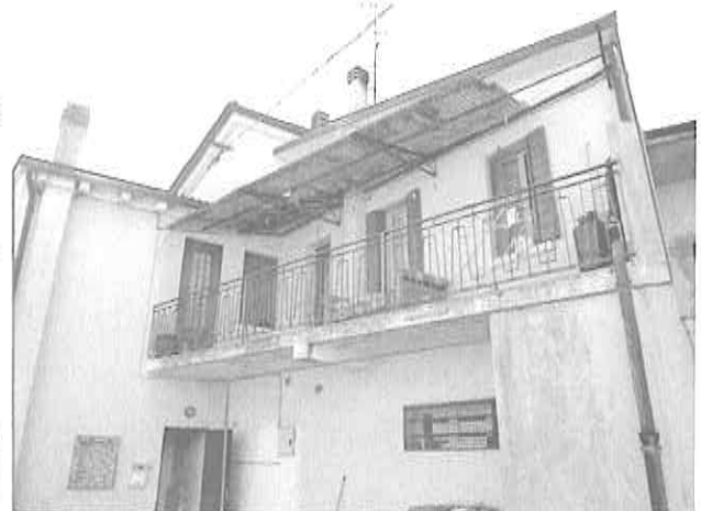
Esterno – vista posteriore (nord)
