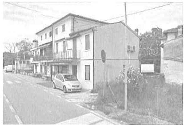
Esterno – fronte nord-est
