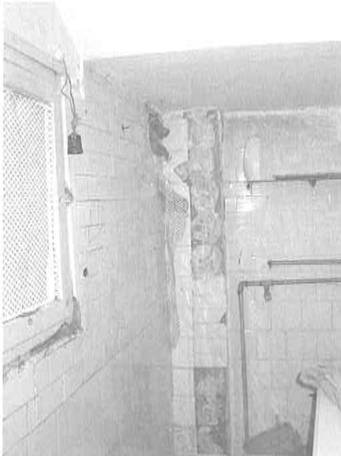
Interno piano terra – ripostiglio sotto-scala
