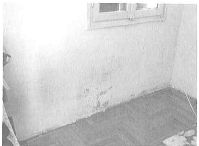
Interno piano primo – altra camera
