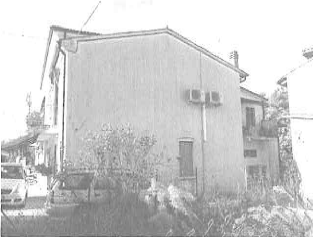
Esterno – fronte nord
