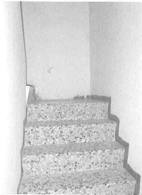
Interno piano terra – scala di accesso al piano 1°
