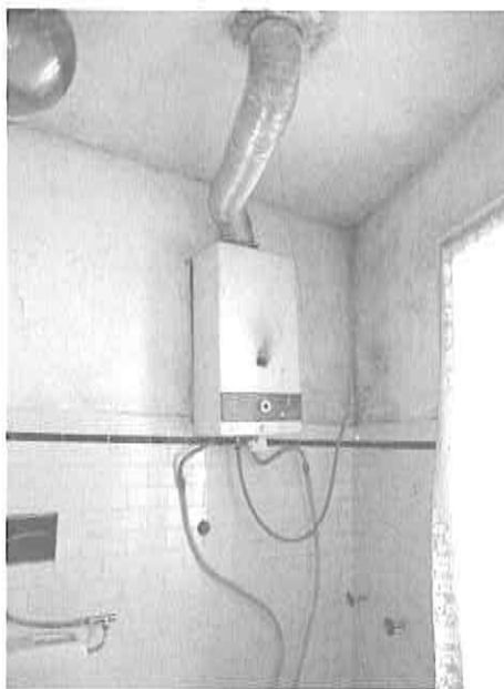
Interno piano primo – bagno (vista 2)
