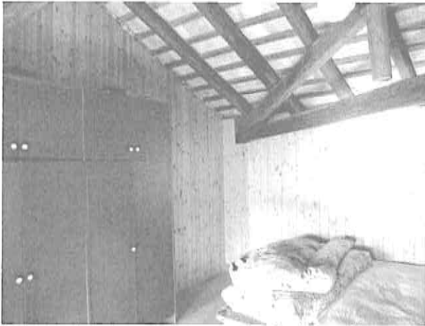
Interno piano secondo – mansarda (vista 1)
