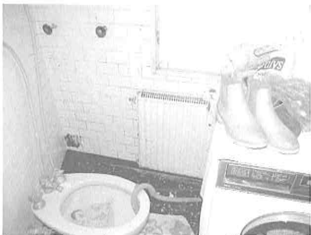
Interno piano primo – bagno (vista 1)
