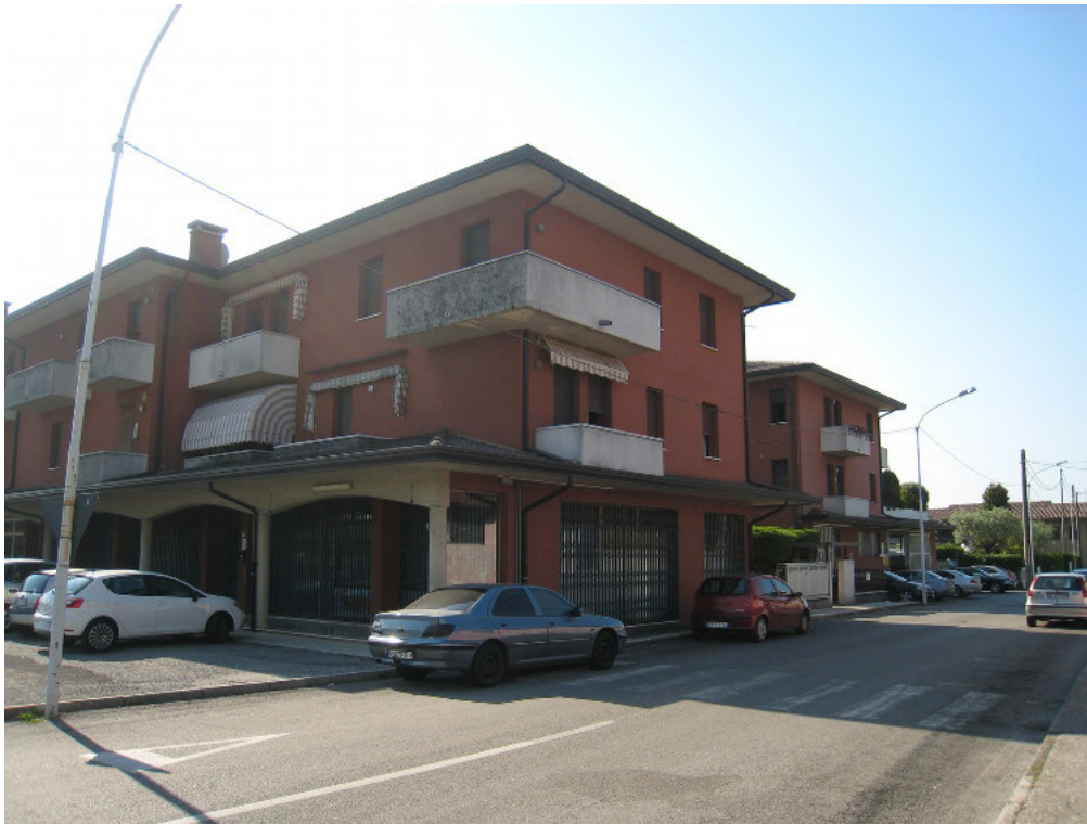
Condominio “Carron” angolo Via Montegrappa-Via Viazza lato Nord-Ovest
