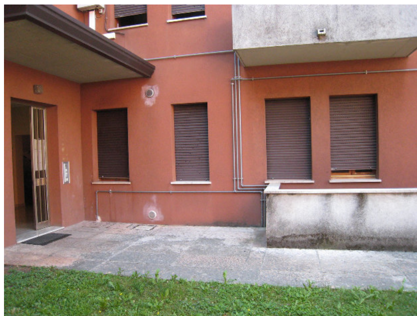
Facciata Est: finestre Cucina, Bagno, Camera 1
