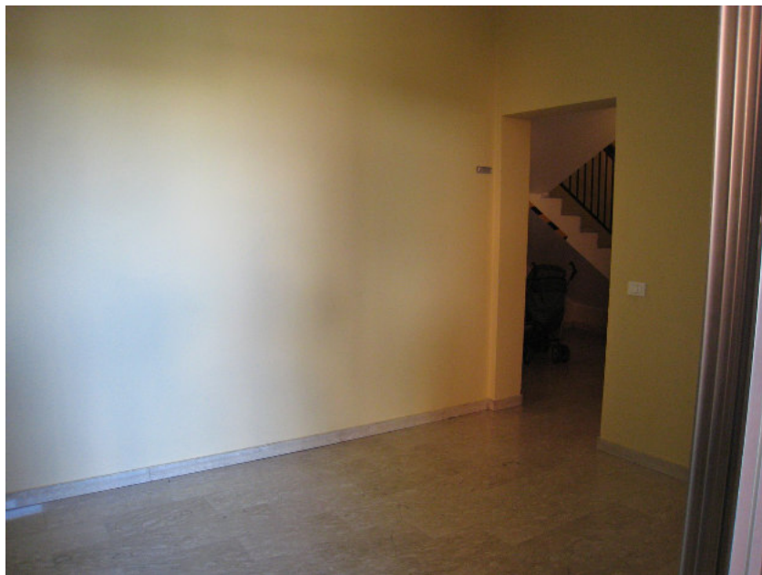
Ingresso e vano scale – Scala C
