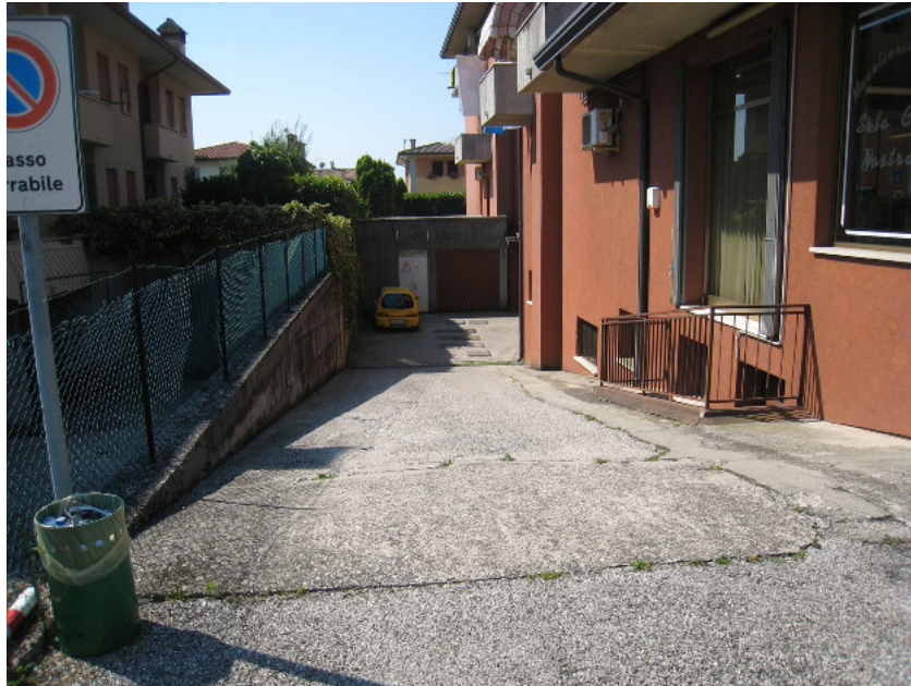
Rampa di accesso interrato lato Nord-Est
