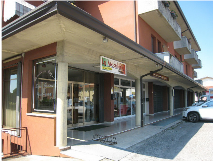
Angolo Nord- Est – Lato rampa
