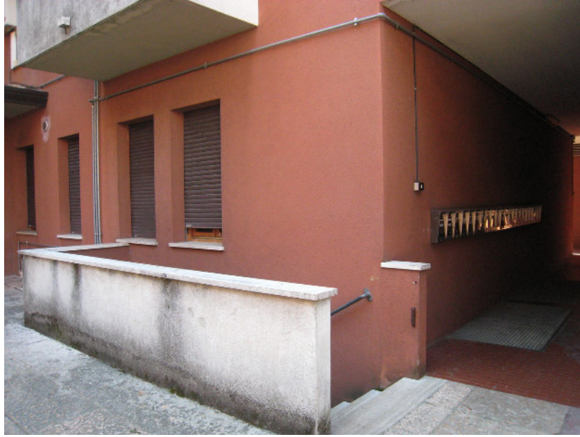
Scala interrato e Tunnel verso lato sud
