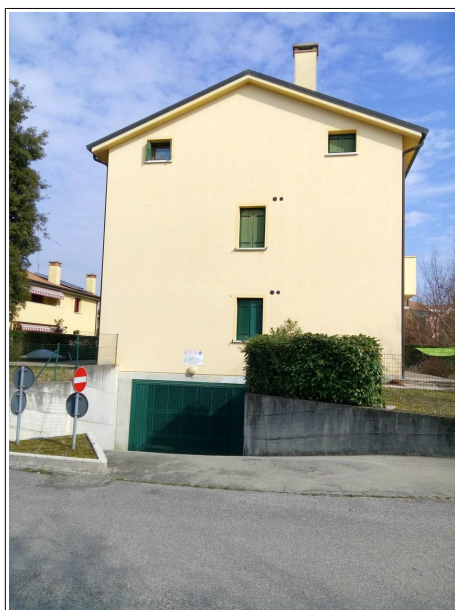
Foto 3 – vista rampa di accesso all'autorimessa condominiale
