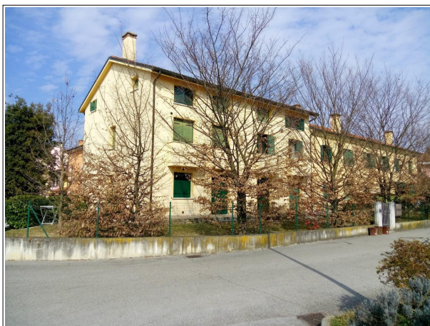
Foto 1 – vista esterna angolo sud
