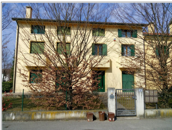
Foto 2 – vista esterna facciata sud-est
