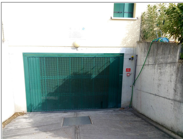
Foto 4 – portone di accesso all'autorimessa condominiale
