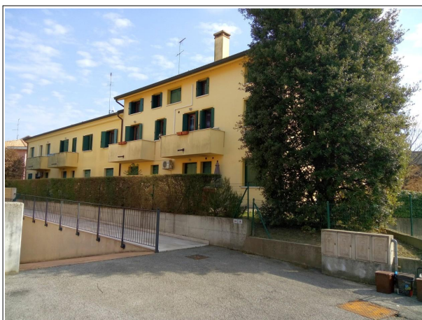
Foto 5 – vista lato nord-ovest
